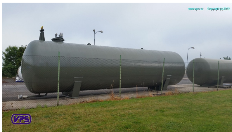
Obrázek 3.12: Tlakový zásobník pro bezpečné skladování LPG, (vpsr.cz, 2022)
