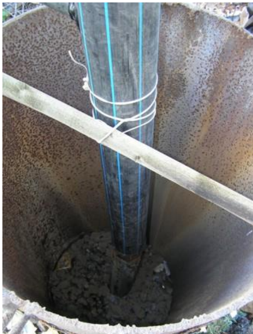
Foto č. 4 - Nastavování odplyňovacích studní (TS Děčín a.s, 2005)
