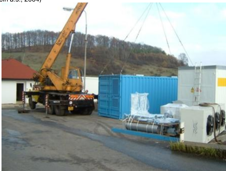
Foto č. 7 - Montáž čerpací stanice (bílý kontejner) a kogenerační jednotky (modrý kontejner) (TS Děčín a.s., 2004)
