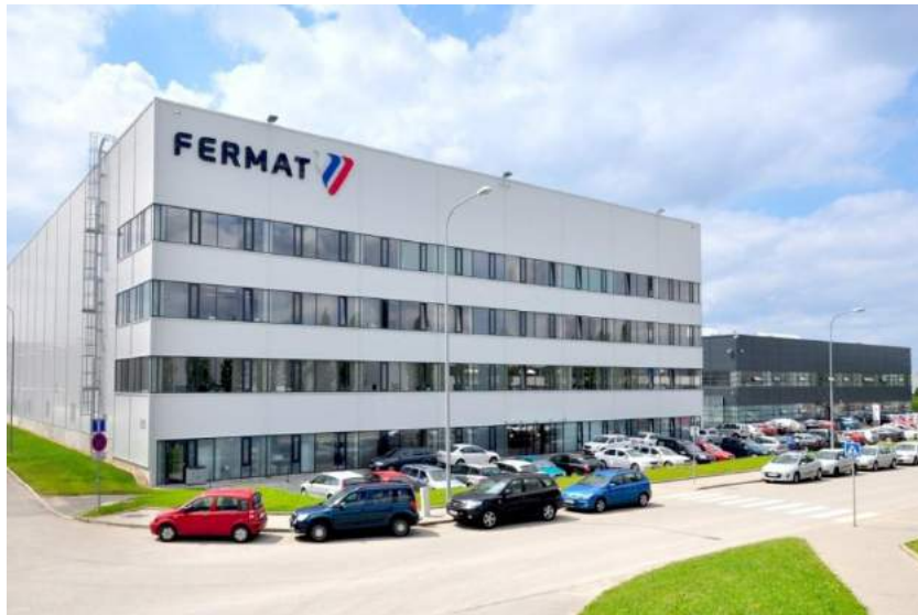
Obr. 4) Výrobní hala společnosti FERMAT v Brně [8]
