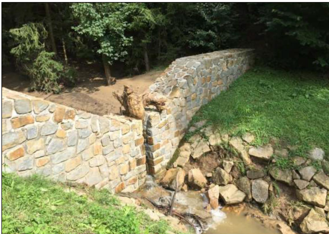
Obrázek 38 Zaplnění přehrázky 1. 8. 2016 po přívalovém dešti (foto LESY ČR)
