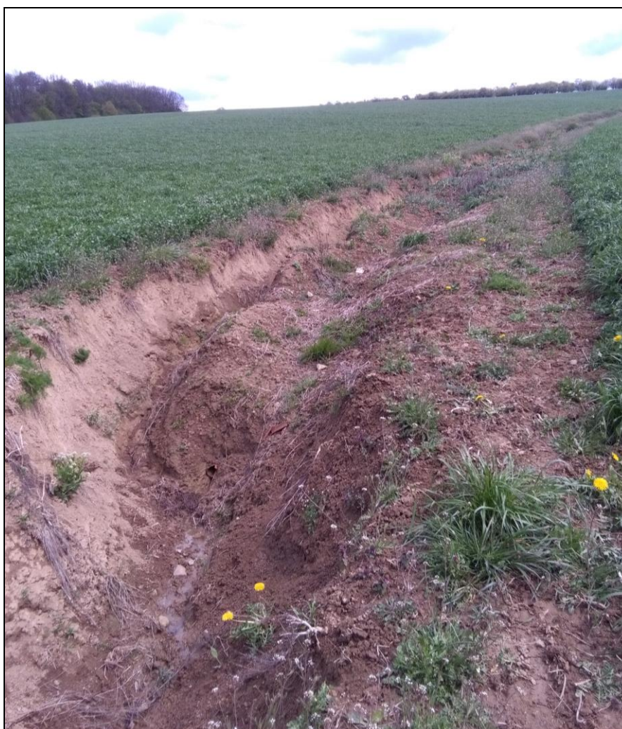
Obrázek 34 Ukázka hluboké rýhy v k. ú. Lužkovice určené ke stabilizaci – SDSO1
