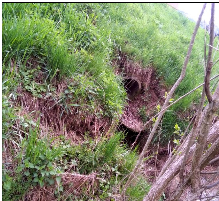
Obrázek 46 Stávající trubní propustek pod cestou C1
