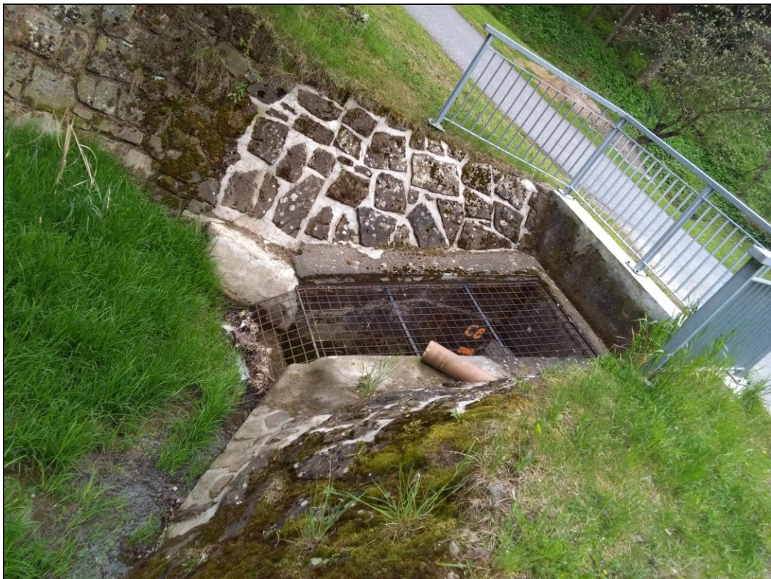
Obrázek 19 Vtok do trubního kanálu
