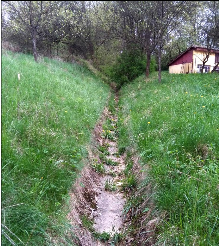
Obrázek 45 Opevněné koryto v intravilánu obce – převádí vodu ze ZP1 do Novinového potoka
