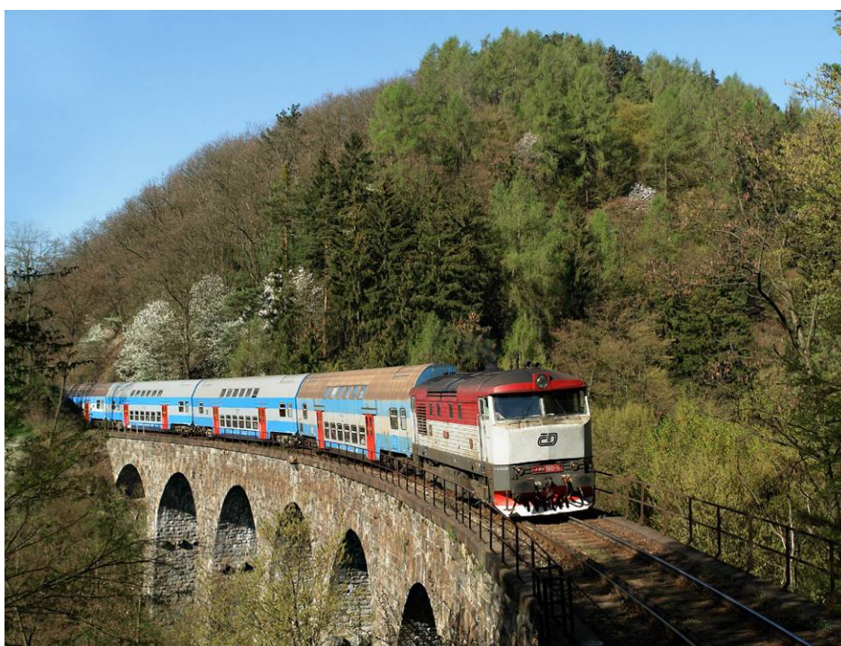
železniční viadukt Žampach
