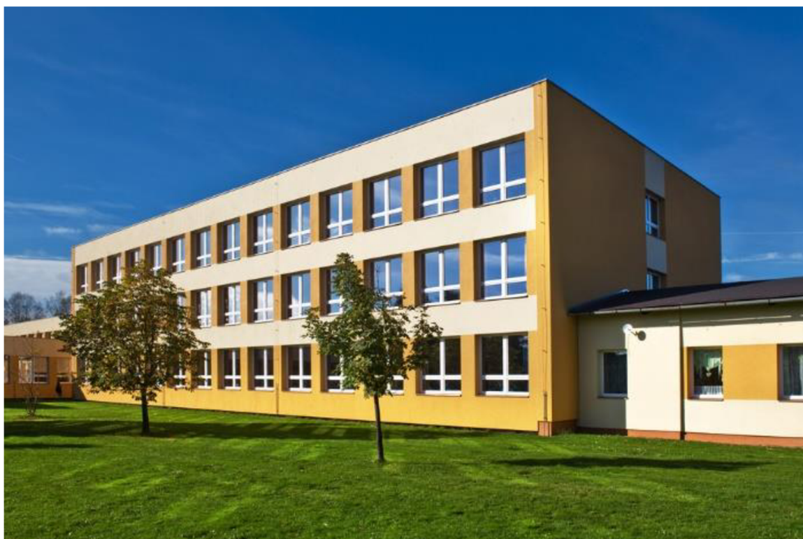
Obr. 7. Úplná základní škola v periferním malém městě Volary – Zdroj: Stavební hmoty Cemix, https://www.cemix.cz/data/reference/j-zvolary1.jpg (31 .3. 2023).
