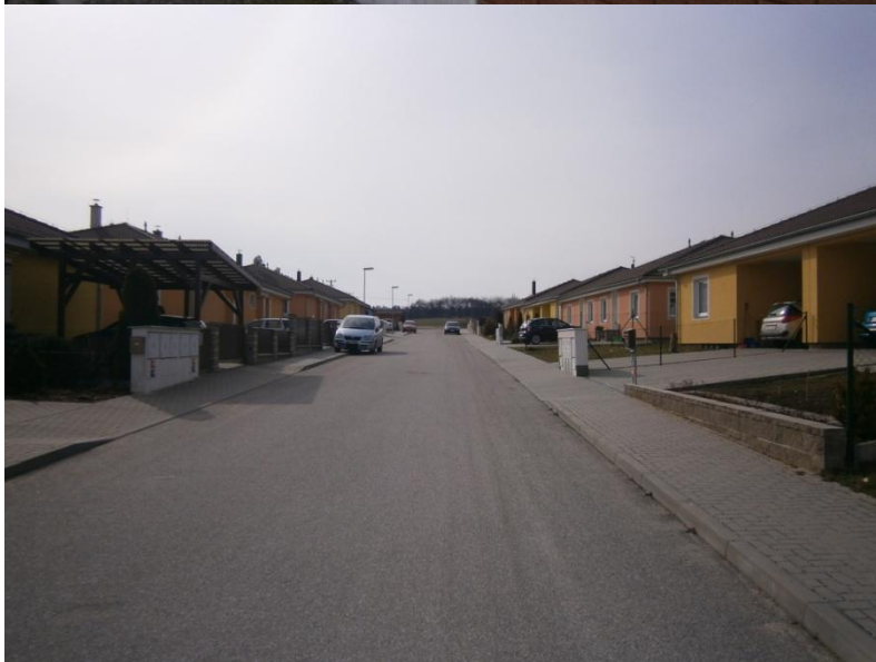
Fotografie 23 a 24 Probíhající a nová výstavba na jihozápadě Lišova - lokalita Na Štěpnicích
