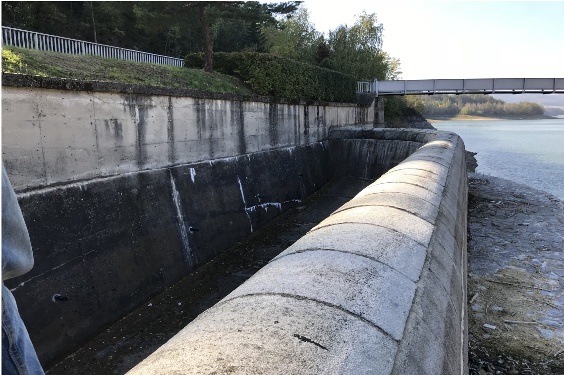
Obrázek 4.9: Detail hrany přelivu [14]
