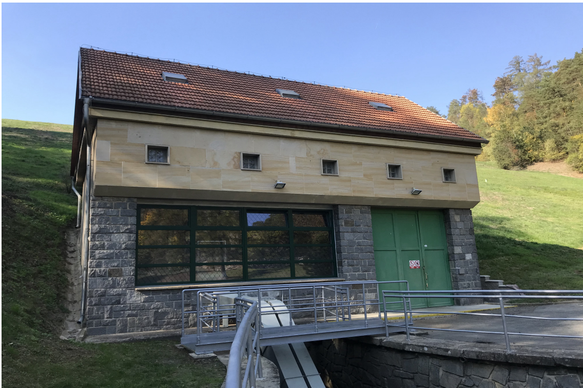
Obrázek 4.7: Malá vodní elektrárna [14]
