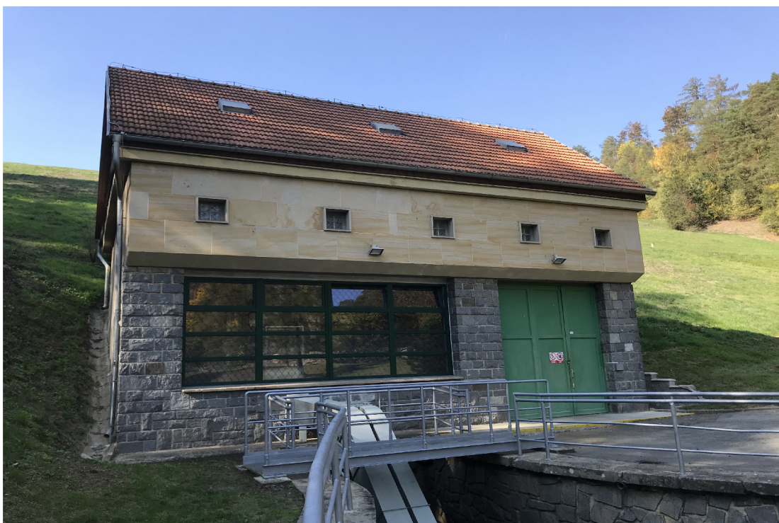
Obrázek 4.7: Malá vodní elektrárna [14]
