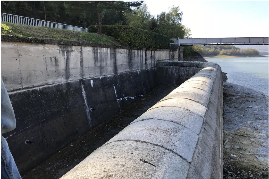
Obrázek 4.9: Detail hrany přelivu [14]
