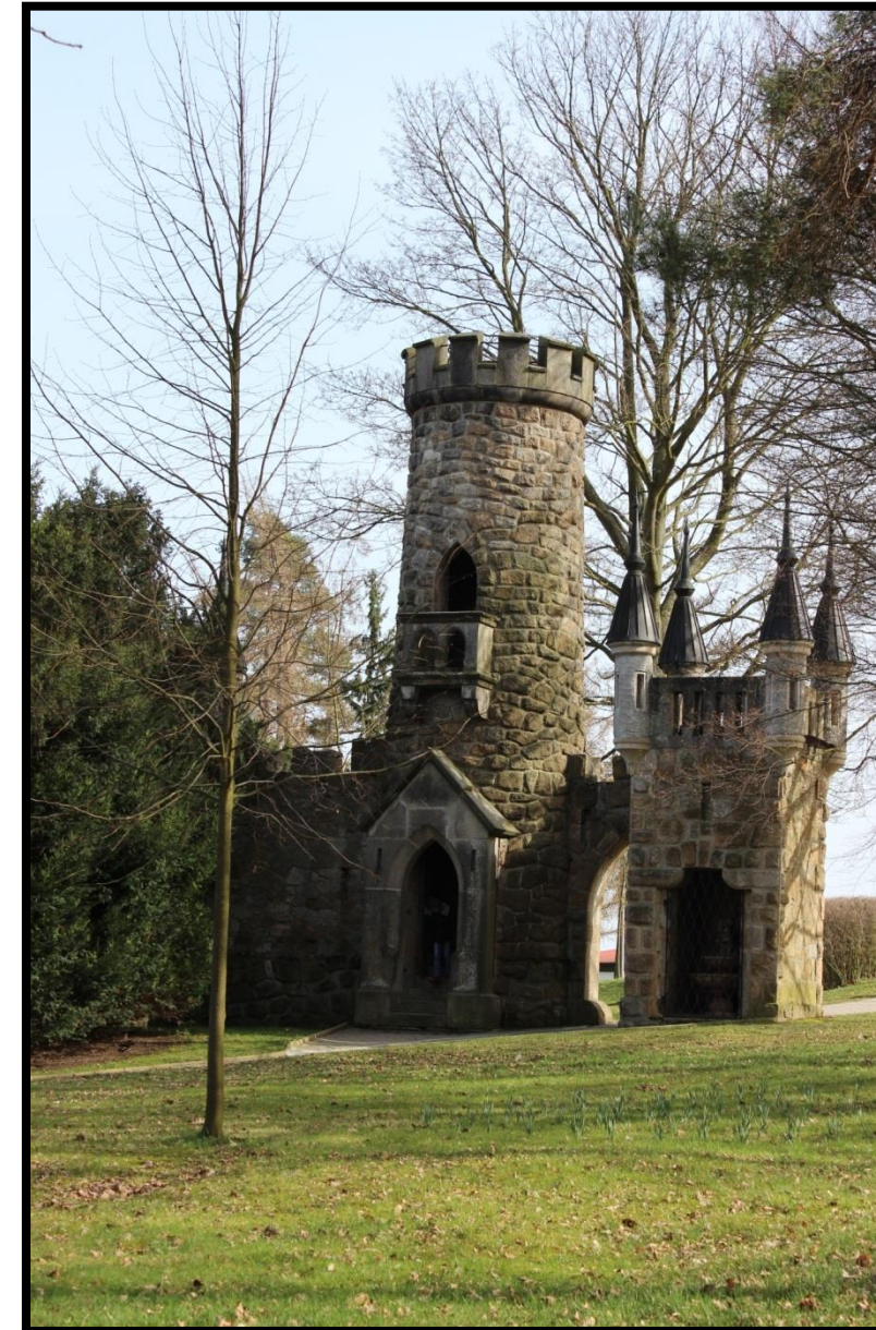
Obr. č. 75: Vyhlídková věž Salingburg (vlastní zdroj, 2016)
