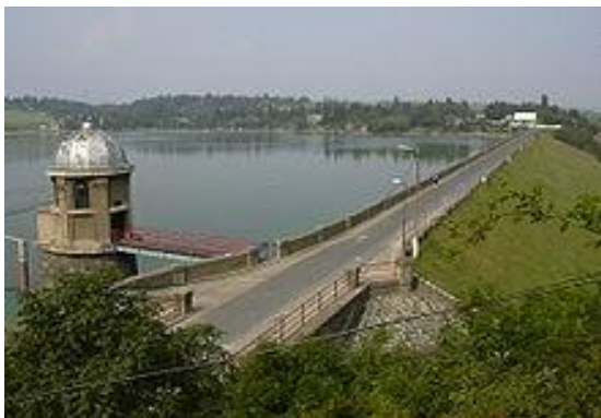
Obr. č.19 – hráz Plumlovské přehrady 31
