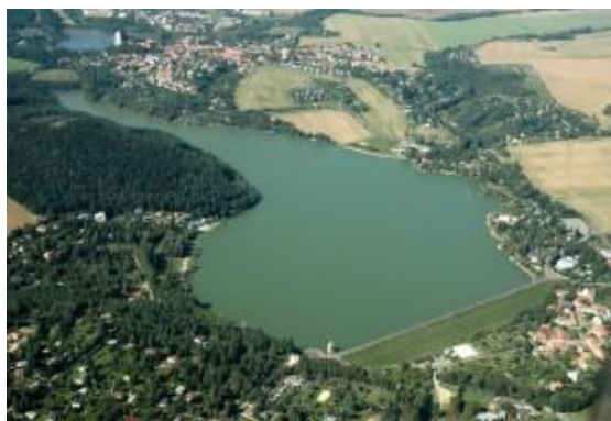
Obr. č.20 - Plumlovská přehrada 32
