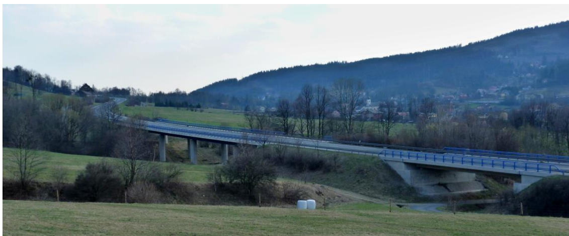
Obr. 21 Silniční obchvat přes obec Mosty u Jablunkova (foto: Denisa Kufová, březen 2019)
