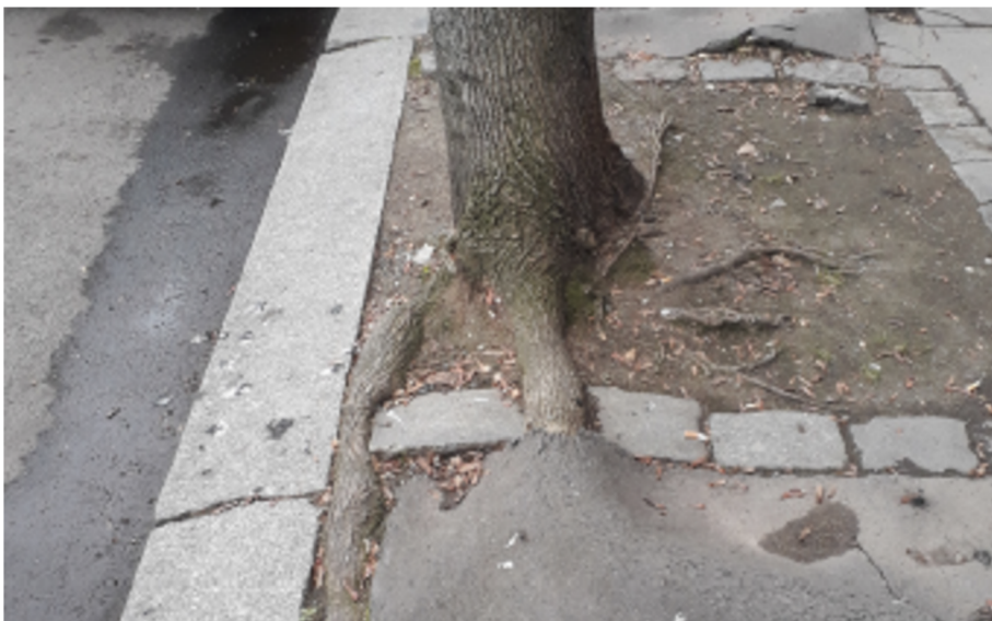
Obrázek č. 1 – Kompenzováním nedostatečného kořenového prostoru strom prorůstá pod okolní povrch (Hora et al. 2022)
