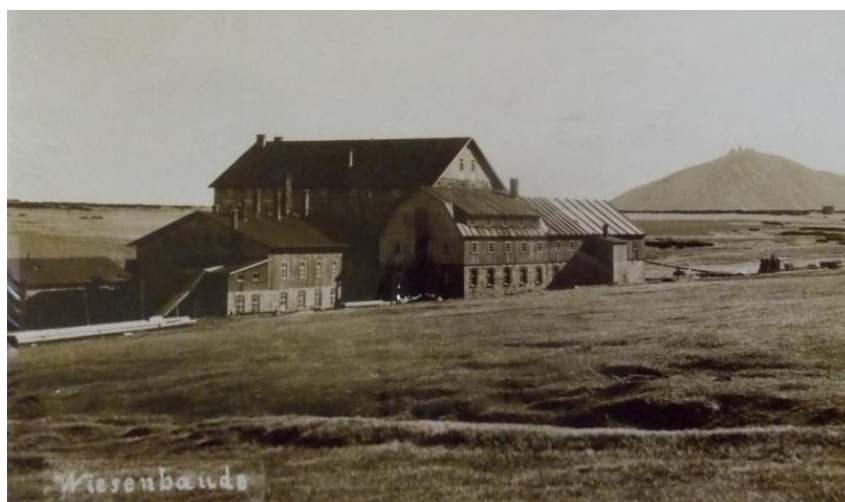
Obr. č. 12: V roce 1914 byla postavena velká budova Luční boudy (Luční bouda 2014)
