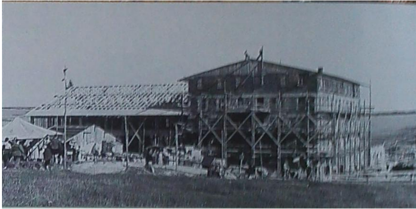
Obr. č. 19: Luční bouda během výstavby po požáru 2. 10. v roce 1938 (Lokvenc 1999)
