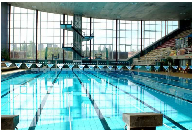
Obr. 5: Plavecký bazén za Lužánkami
