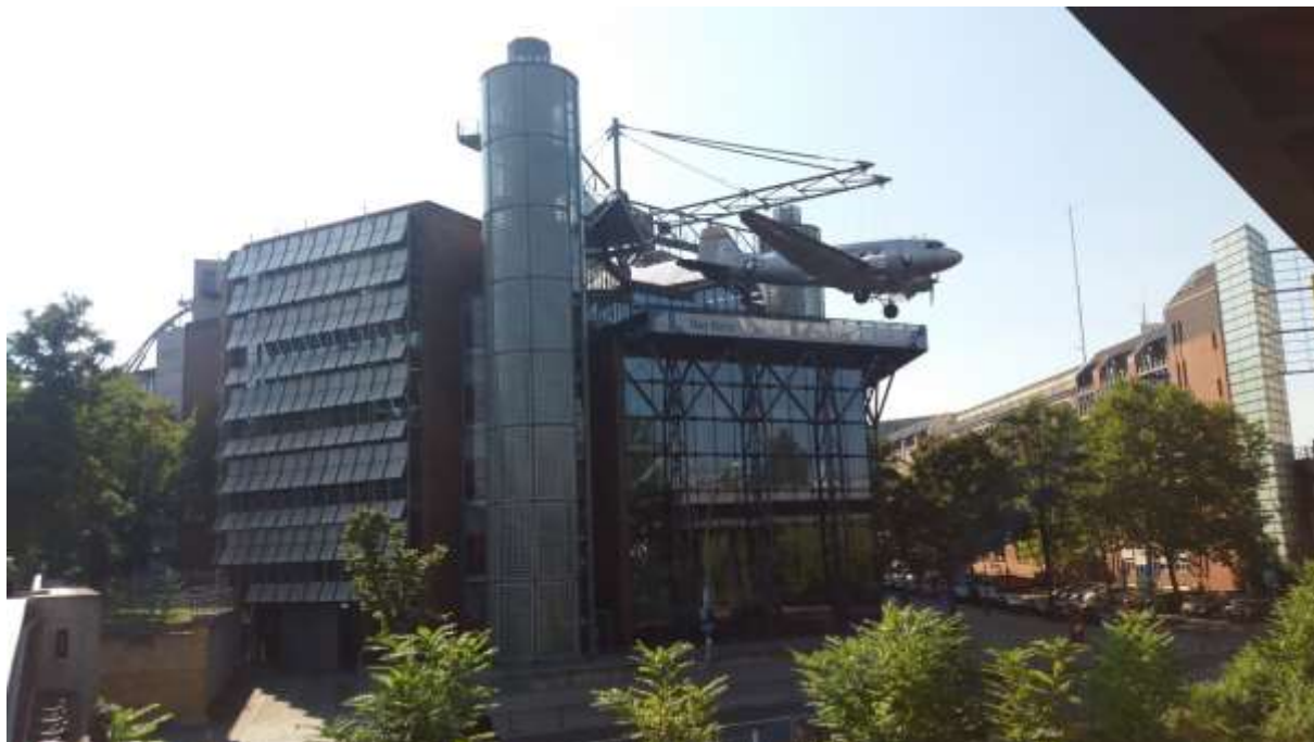
Obrázek 4.: Pohled na novou budovu DTMB
