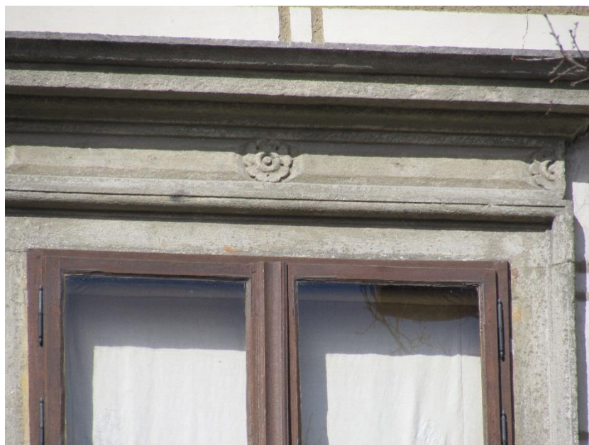
3. Motiv rožmberské růže, kamenné ostění oken, jižní strana jihovýchodního nároží zámku.
