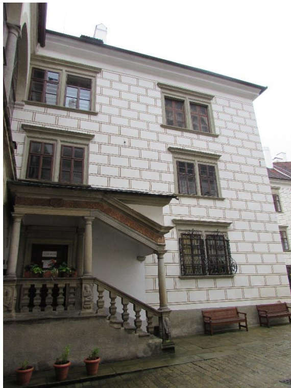
22. Velký dům, východní dvorní fasáda.
