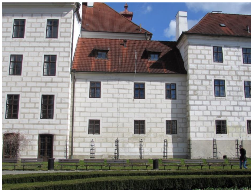
15. Spojovací krček mezi západním křídlem a budovou bývalého pivovaru, západní strana.
