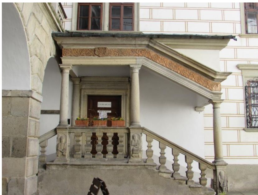
23. Schodiště při Velkém domu.
