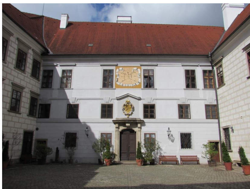
18. Severní křídlo, dvorní fasáda.
