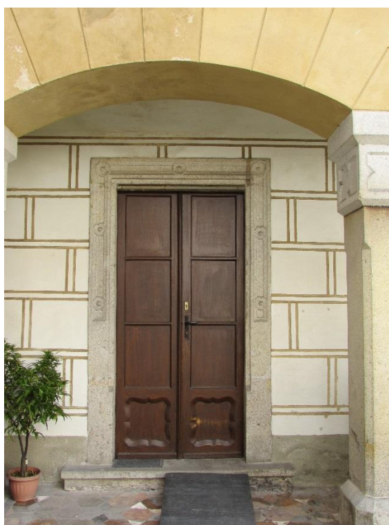
20. Vchod do budovy západního křídla pod arkádou, dvorní fasáda.
