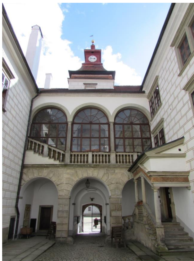
16. Jižní křídlo s arkádou, dvorní fasáda.
