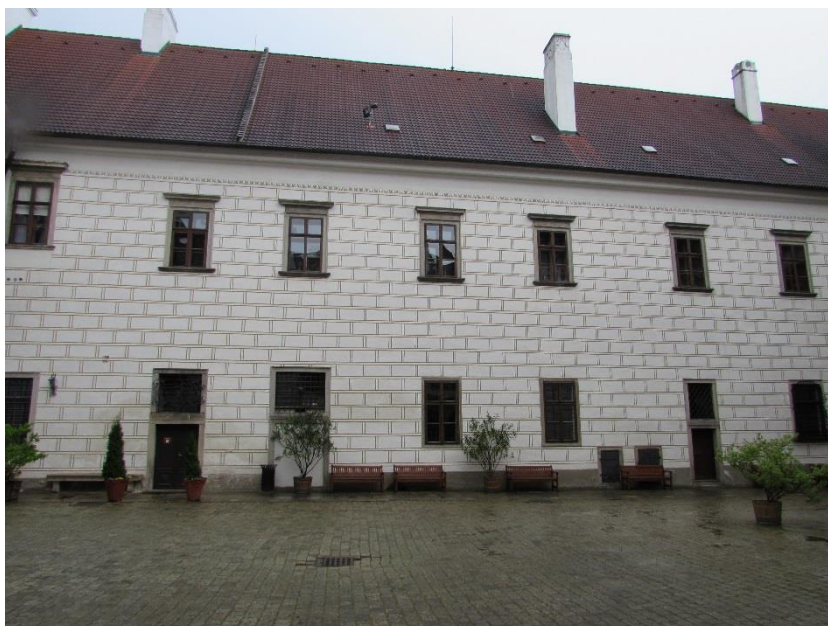
17. Východní křídlo, dvorní fasáda.
