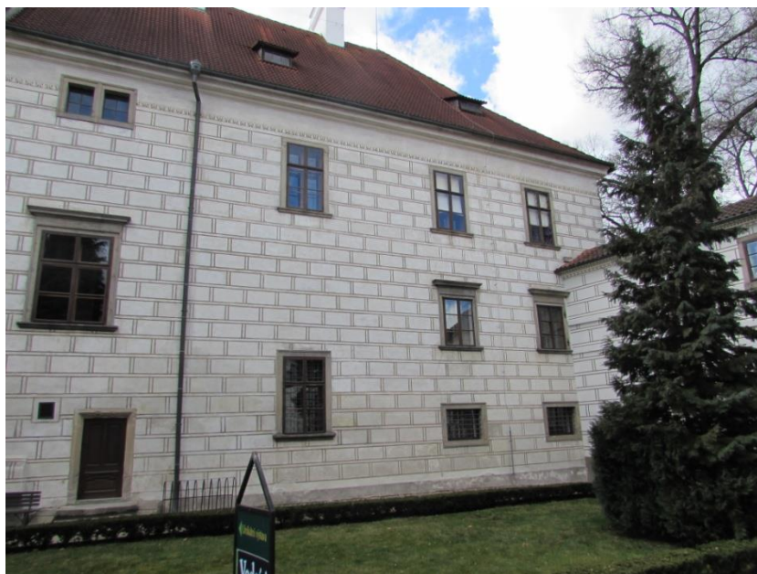
5. Severní část východního křídla, východní strana.
