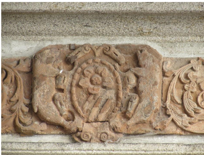
25. Rožmberský znak – terakotový vlys – schodiště při Velkém domu.
