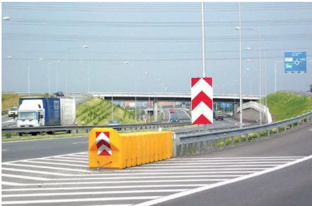
Obrázek 5 - Tlumič nárazu
