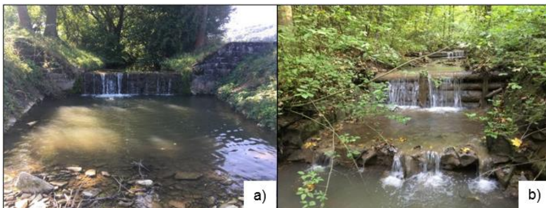
Obr. 25: a) Kamenný stupeň v intravilánu obce, b) dřevěný stupeň v extravilánu obce (foto: P. Škubník, září 2021)
