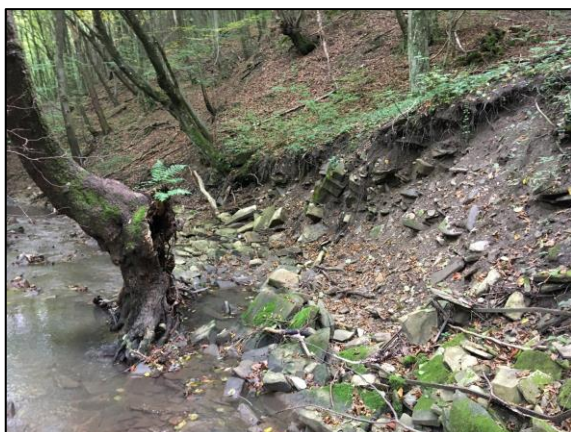
Obr. 40: Břehová nátrž ve středním úseku Zelenského potoka (foto: P. Škubník, říjen 2021)
