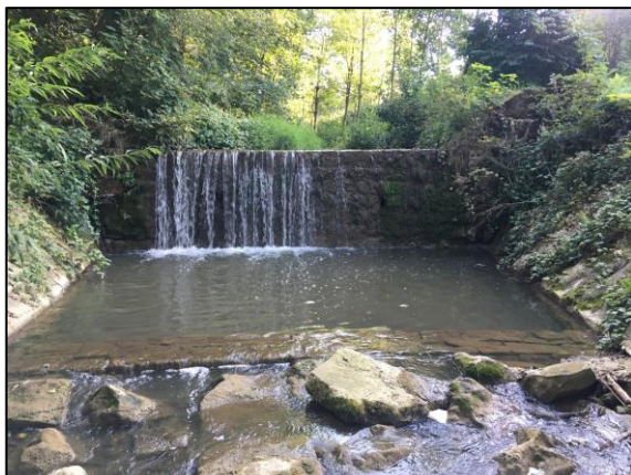
Obr. 46: Kamenný stupeň na 1,6. ř. km Zelenského potoka (foto: P. Škubník, září 2021)
