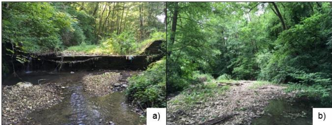
Obr. 24: a) Retenční přehrážka za intravilánem obce, b) ukázka nádržního prostoru zaneseném splaveninami (foto: P. Škubník, červen 2021)
