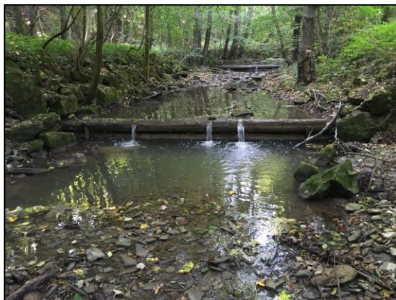
Obr. 47: Dřevěný stupeň na 2,2. ř. km Zelenského potoka (foto: P. Škubník, září 2021)
