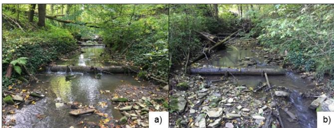
Obr. 26: a) Ukázka funkčního dřevěného prahu, b) nefunkčního dřevěného prahu v horním úseku Zelenského potoka (foto: P. Škubník, říjen 2021)
