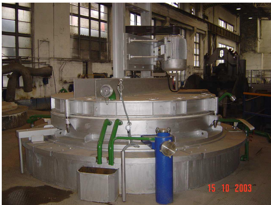
Obrázek č. 14 „Vakuové odzinkování olov po odstříbění“
