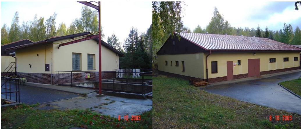
Obrázek č. 8 „Čistírna odpadních vod splaškových“
