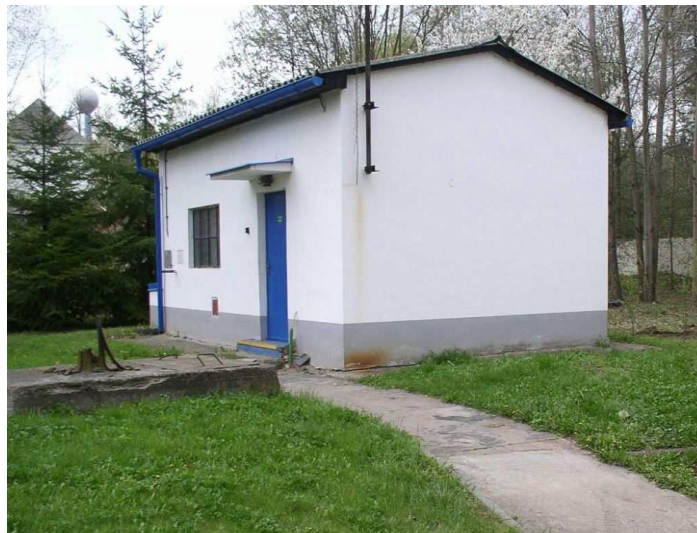
Obrázek č. 7 „ Čistírna dešťové odpadní vody“
