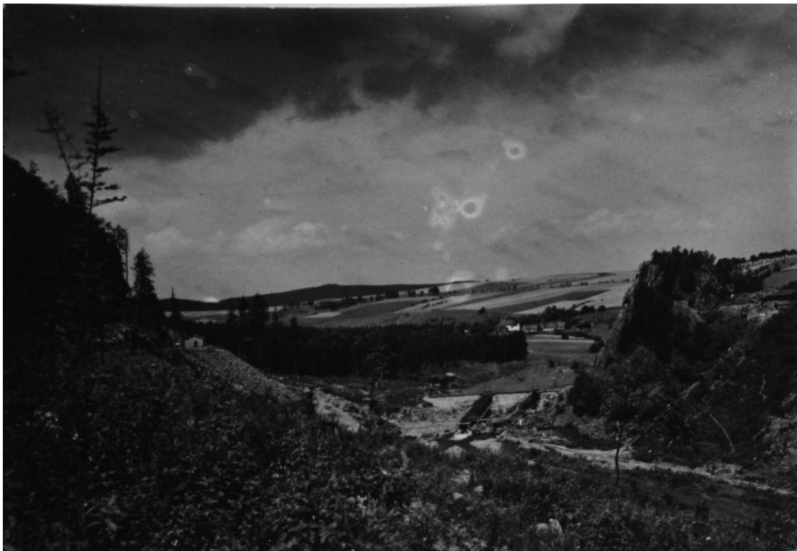
Obr. 13 Pohled na budoucí místo hráze 1927
