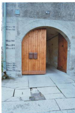
Značky velkých vod v Křešicích na domě čp. 19 (foto L. Elleder). Rozhraní světlejší a tmavší barvy nad vraty indikuje výšku, do které vystoupila voda v Labi při povodni v srpnu 2002.
