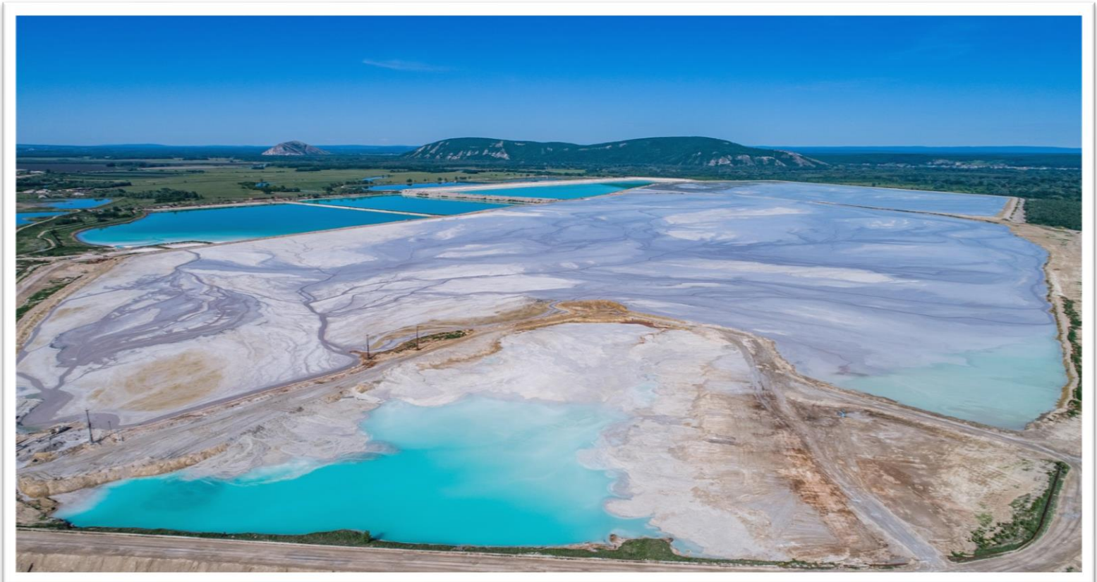
Изображение 38. Шламонакопители. Жидкие отходы 2 (Стерлитамак с высоты 2022).
