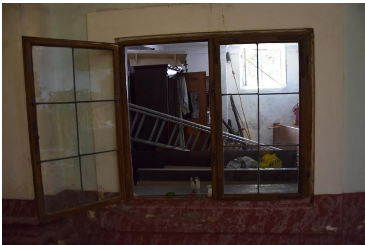
Příloha č. 53: Původní barokní okno v sakristii
