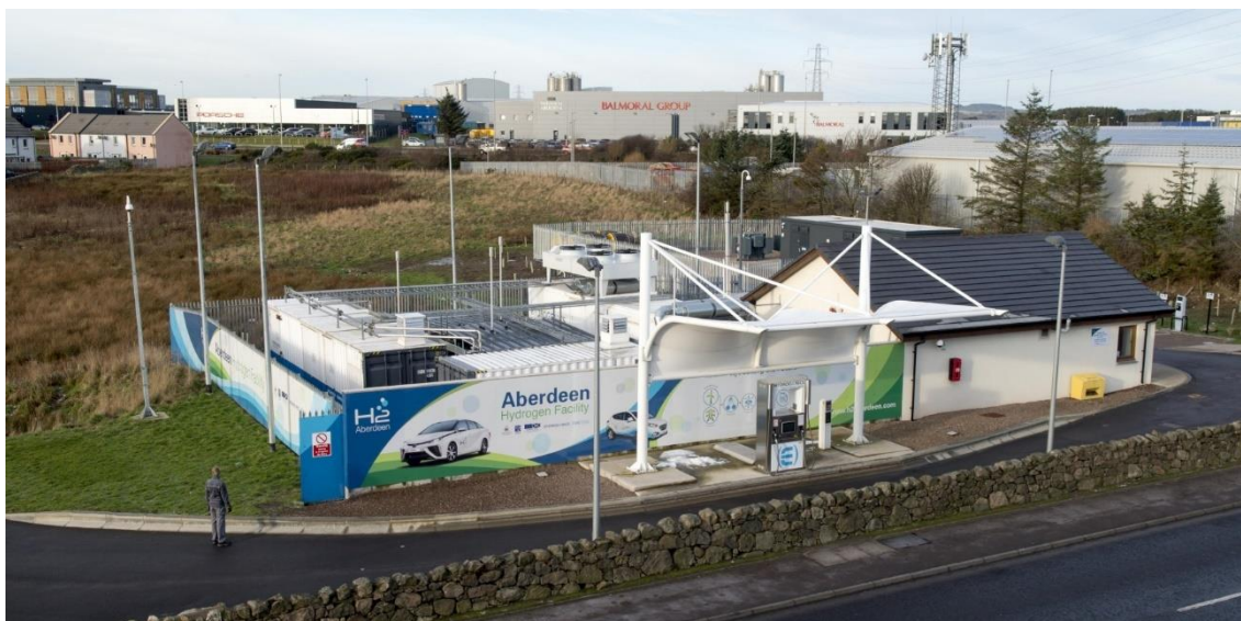
Obr. 3.4 Čerpací stanice se zařízením pro výrobu zeleného vodíku
