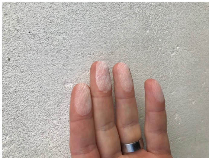
Obr. č. 27: Sprašování a křídování finální vrstvy fasády; zdroj: vlastní
