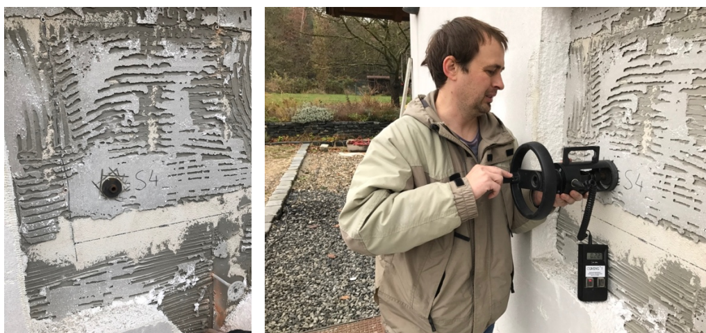
Obr. č. 36 vlevo: Příprava odtrhové zkoušky podkladu původního ETICS; zdroj: vlastní
