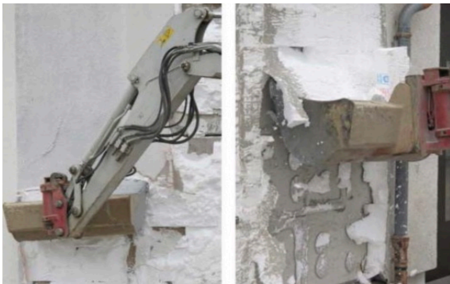
Obr. č. 53 vlevo: Strojní demontáž celého souvrství ETICS; zdroj: www.czb.cz
