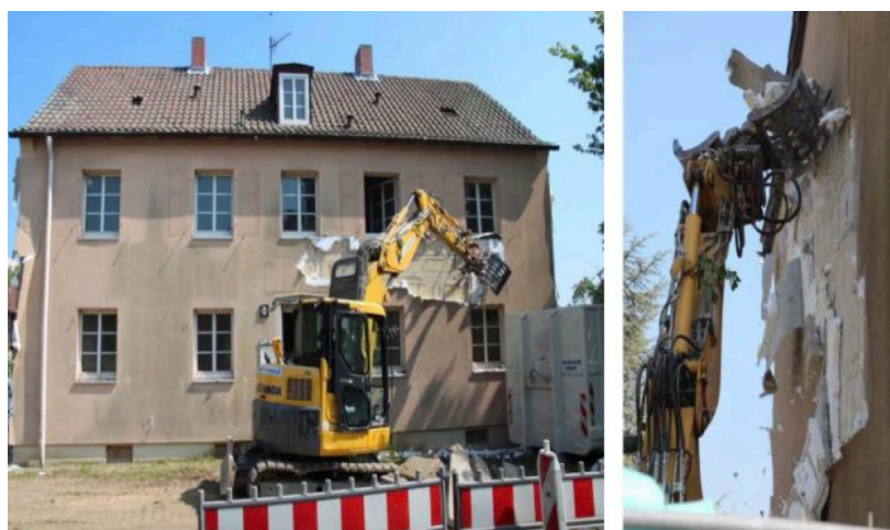
Obr. č. 16: Demontáž ETICS s pěnovým polystyrenem; zdroj: www.epscr.cz
