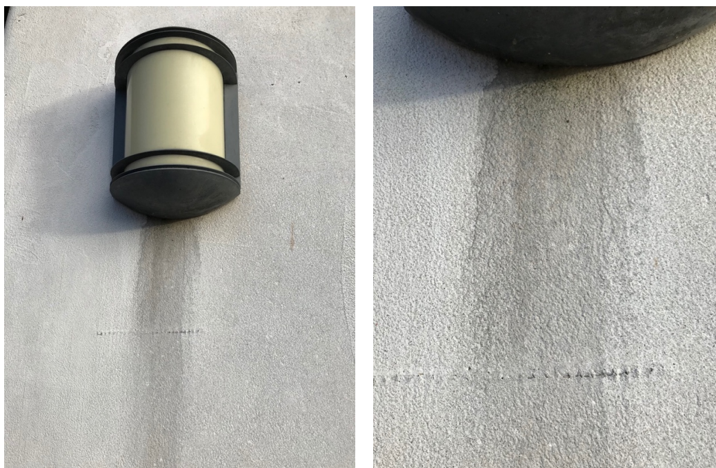
Obr. č. 28 vlevo: Místo napadeného řasami; zdroj: vlastní
