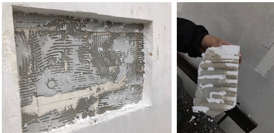
Obr. č. 38 vlevo: Způsob lepení původního izolantu; zdroj: vlastní
