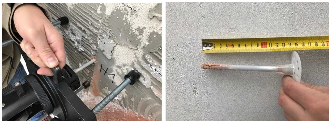
Obr. č. 40 vlevo: Průběh odtrhové zkoušky taliřové kotvy; zdroj: vlastní
