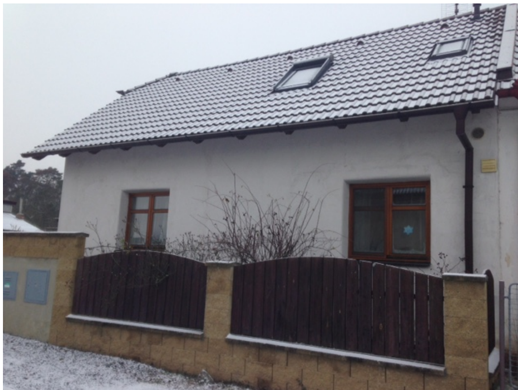
Příloha č. 7 – Pohled z ulice po demontáži vrchní vrstvy původního zateplení; zdroj: vlastní
