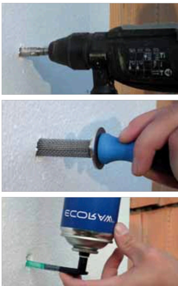
Obr. č. 63 nahoře: Předvrtání kotevního místa; zdroj: www.ecoraw.eu
