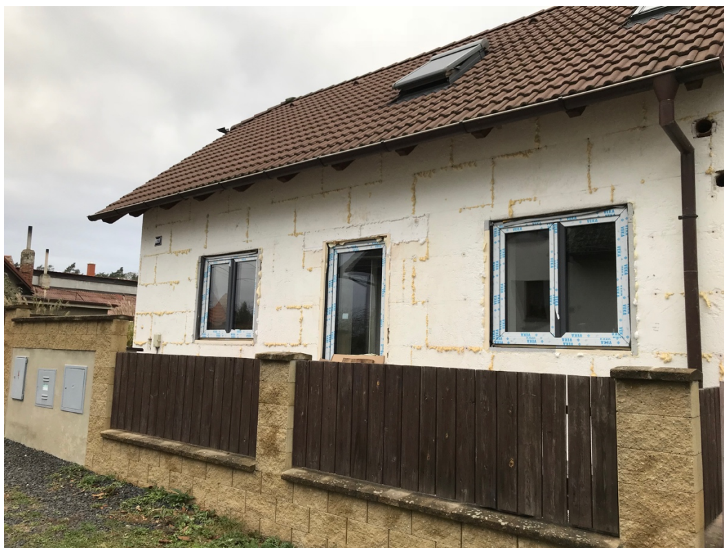
Příloha č. 7 – Pohled z ulice po demontáži vrchní vrstvy původního zateplení; zdroj: vlastní
