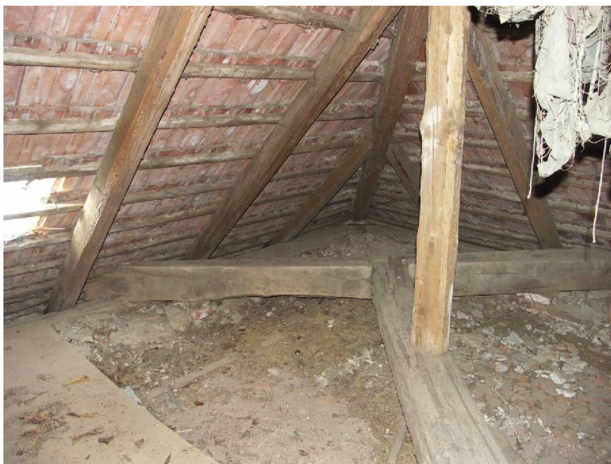
Obr. 3.5 Nárožní krokev a výměna
