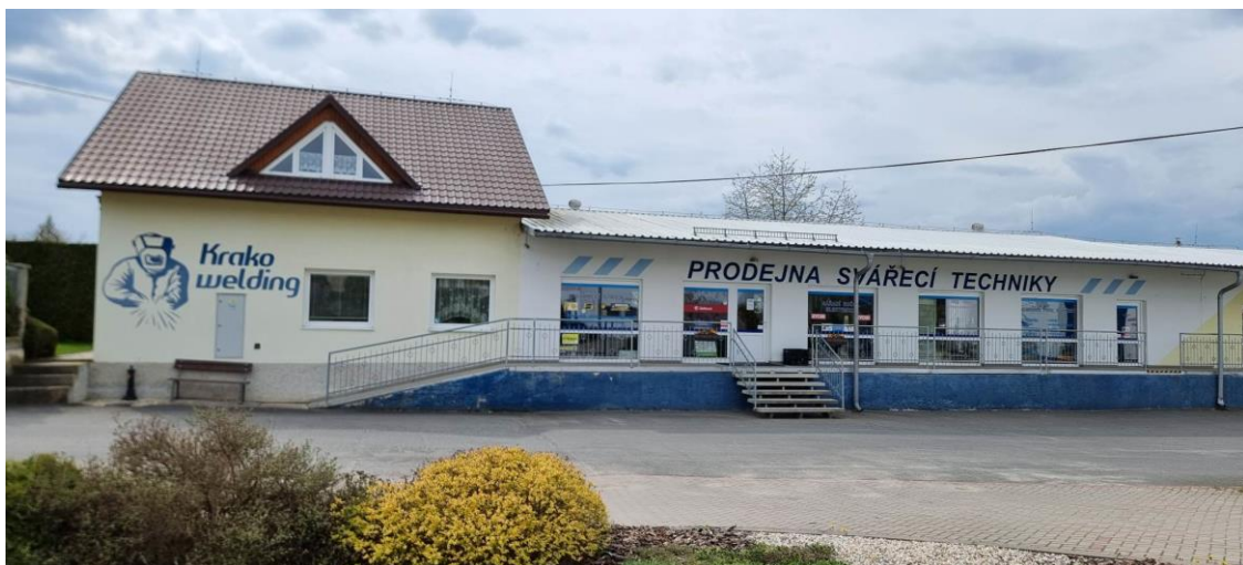
Obrázek 25 Fotografie budovy [Vlastní zpracování]
