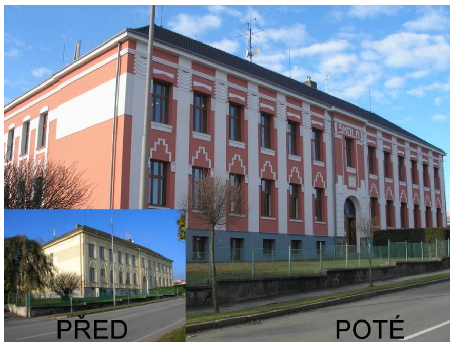
Obrázek 4: Rekonstrukce budovy školy v Horní Cerekvi
