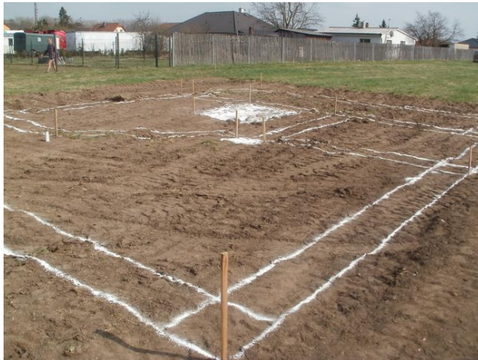
Obrázek 63 – Vyvápnění obrysu stavby s použitím kolíků [21]
