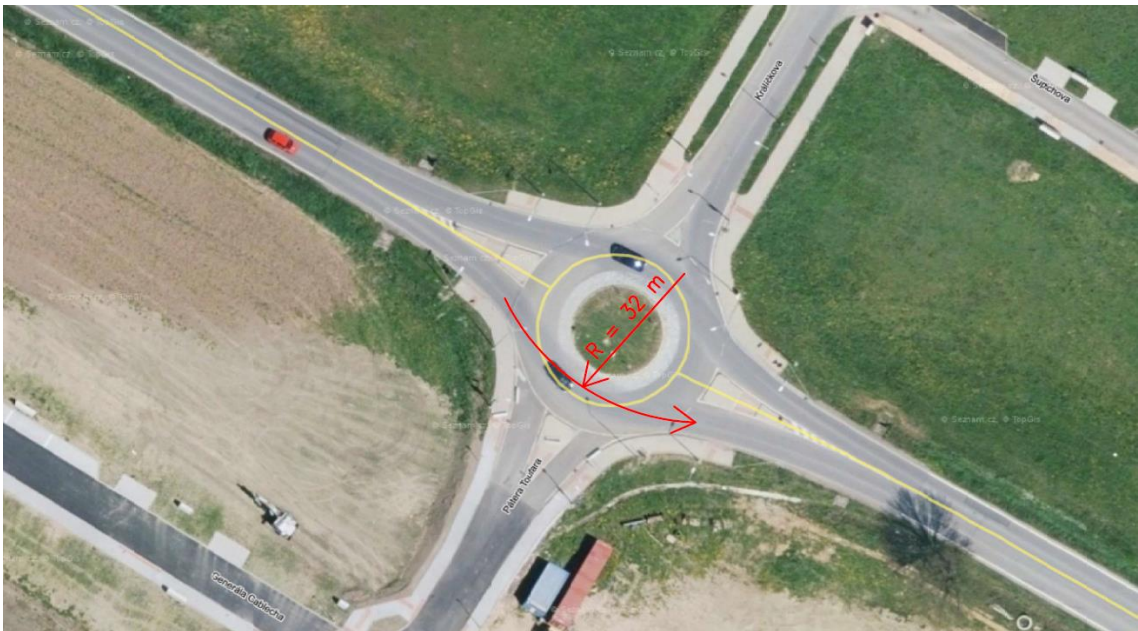
Obrázek 40 – Kritické místo F4 směr ze stavbu [12]
