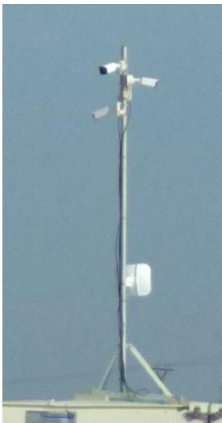
Obrázek 114 – Příklad montáže na staveništní buňky detail
