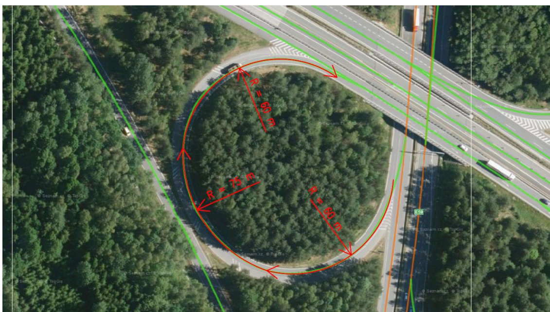
Obrázek 42 – Kritické místo F9 směr ze stavbu [12]
