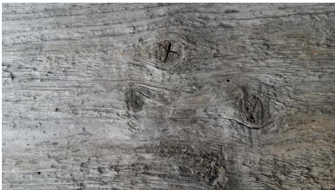
Obr. 10: Povrch starého zdegradovaného jedlového dřeva před odstraněním nečistot z povrchu
