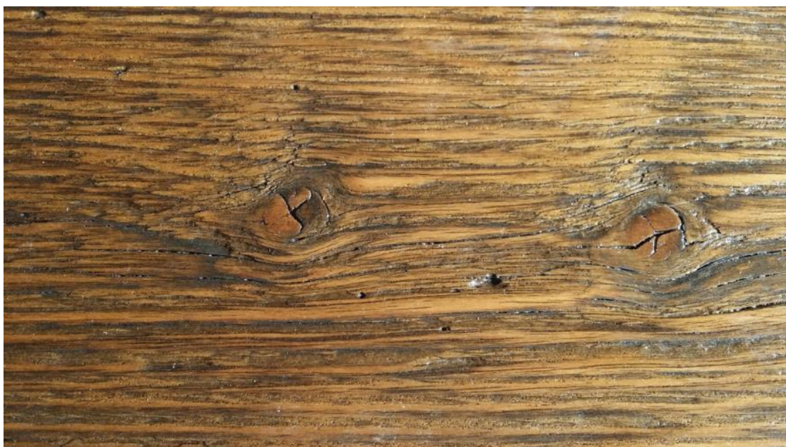
Obr. 27: Povrch zdegradovaného dřeva povrchově dokončen nitrocelulózovou nátěrovou hmotou
