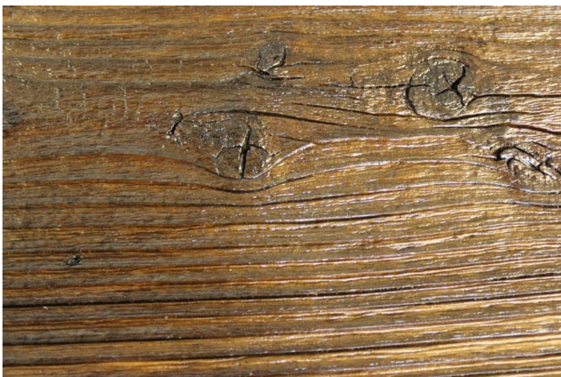
Obr. 29: Povrch zdegradovaného dřeva povrchově dokončen polyuretanovou nátěrovou hmotou
