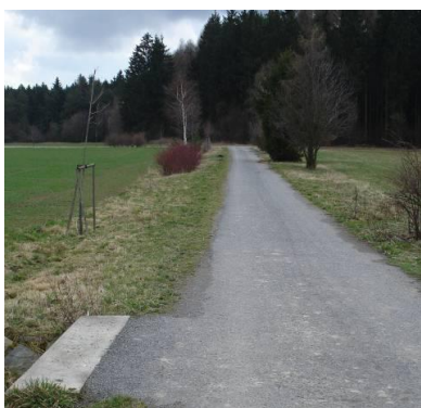
Obrázek 13: Cesta C2 s propustkem
