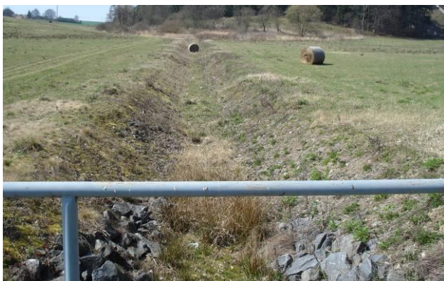
Obrázek 23: Záchytný příkop
