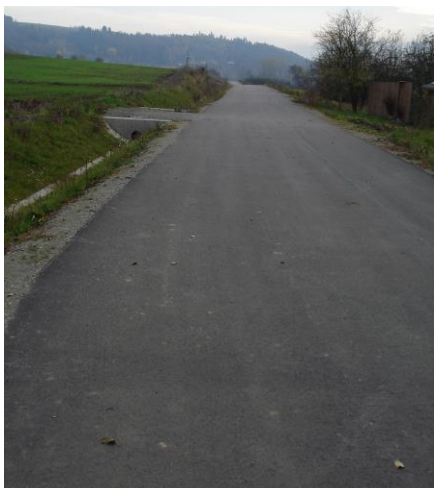
Obrázek 17: Cesta CHN1 s propustkem
