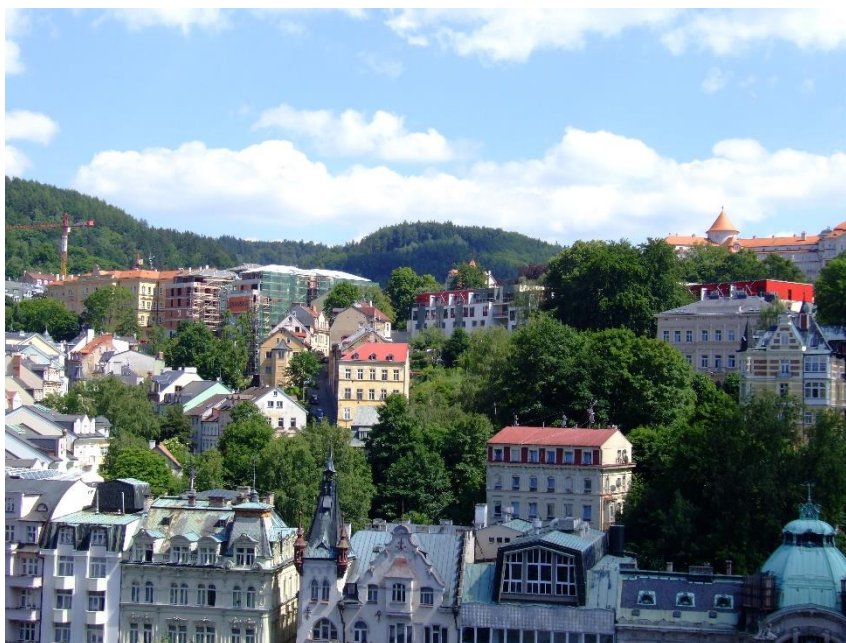
Obrázek 10 - pohled na novou výstavbu rezidence Královská vyhlídka, včetně novostavby garážového domu (autor: Klub Za krásné Karlovarsko)
