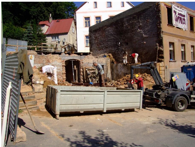
Obrázek 1- demolice domů Saxonía a Mantua (autor: Klub Za krásné Karlovarsko)
