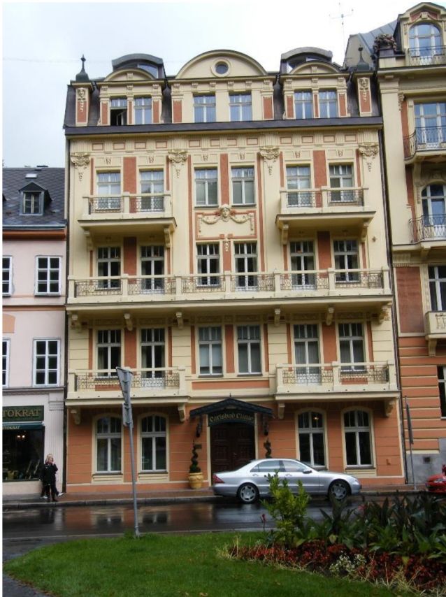
Obrázek 7 – zachovaná čelní stěna domu Eboli (autor: Klub Za krásné Karlovarsko)
