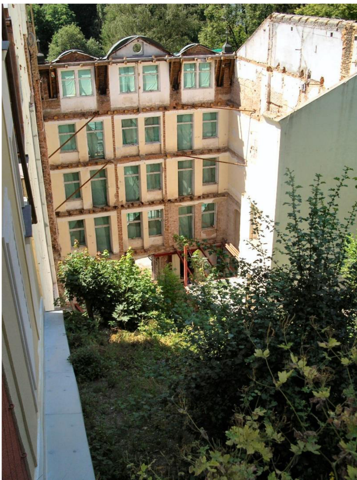
Obrázek 6 - proces vybourání interiéru domu Eboli (autor: Klub Za krásné Karlovarsko)
