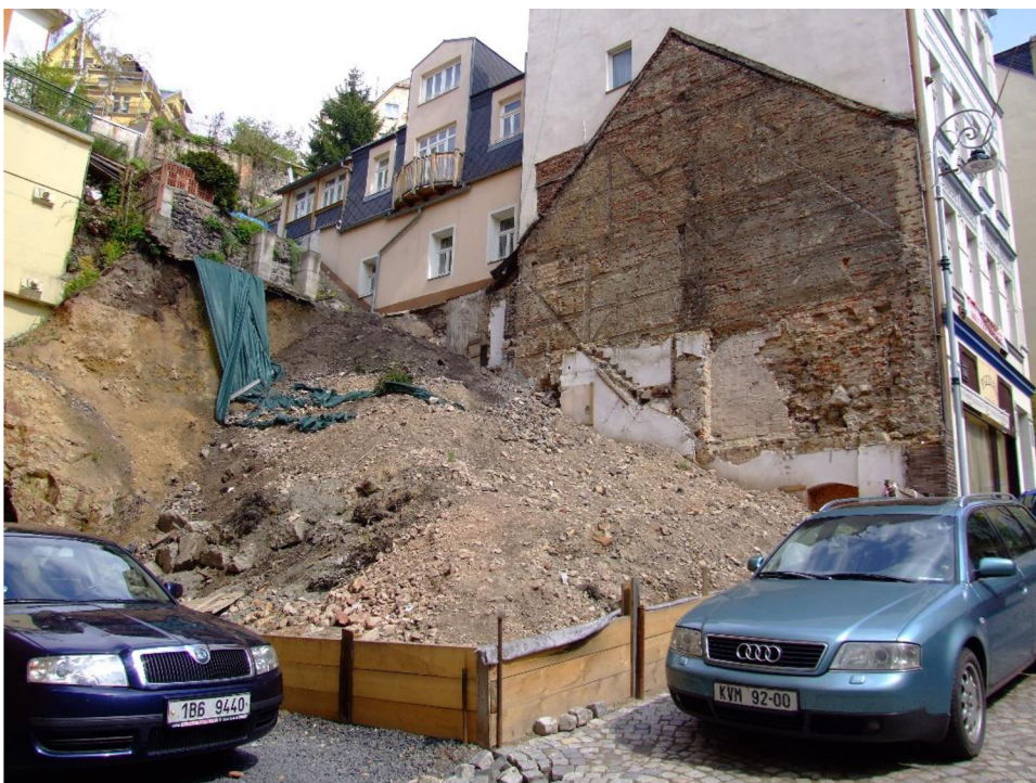
Obrázek 4 - demolice domů v Moravské ulici (autor: Klub Za krásné Karlovarsko)
