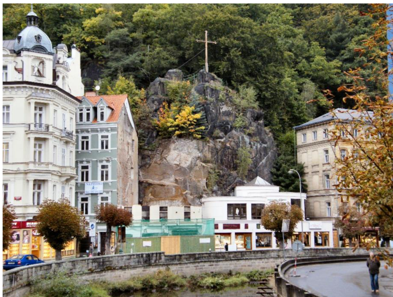
Obrázek 2 - Dům Tři vlaštovky po demolici (autor: Klub Za krásné Karlovarsko)
