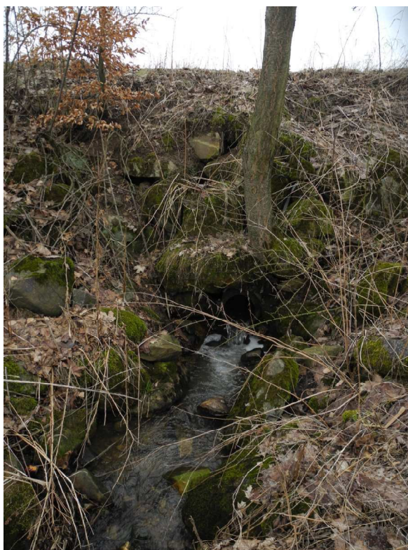
Foto č. 6: Odpadní potrubí s vývarem
