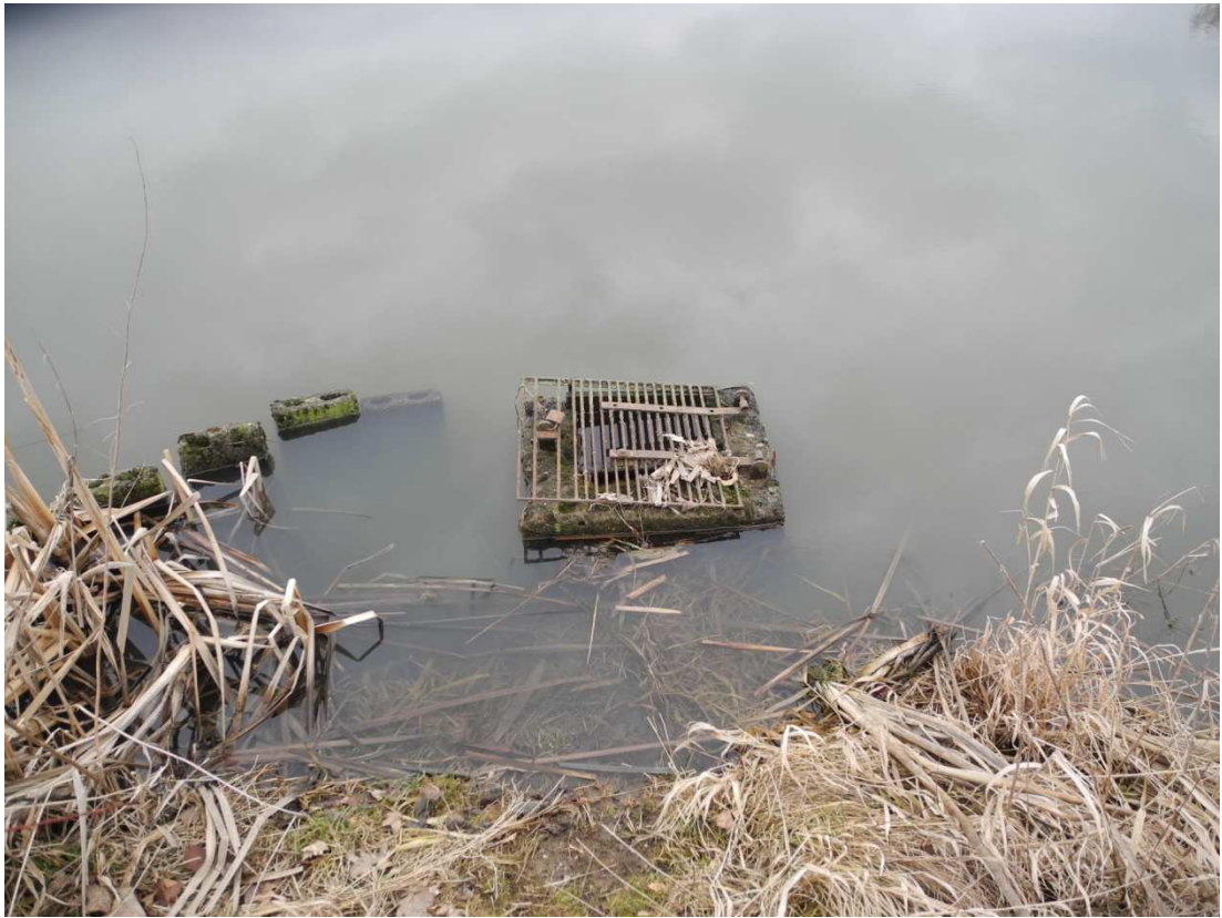
Foto č. 3: Současné výpustné zařízení
