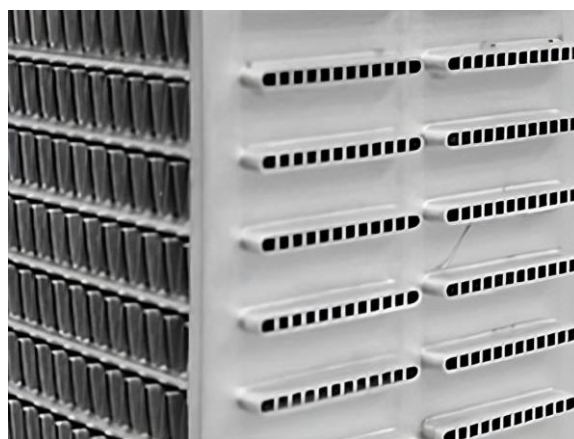
Obr. 44 Trubky zapájené v těle výměníku [37]
