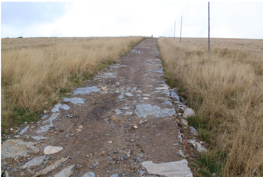
Obr. 19: Štětování Jantarové cesty částečně zakryté jemnozrnným materiálem. Foto autor
