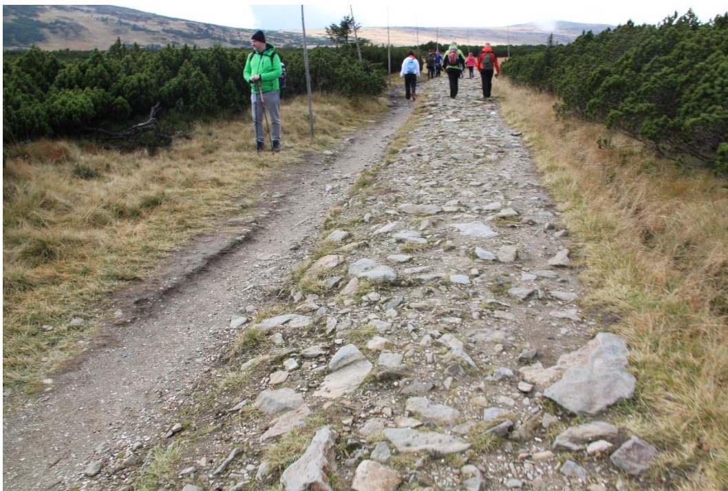
Obr. 32: Původní rozbité těleso chodníku Schustlerovy cesty. Foto autor
