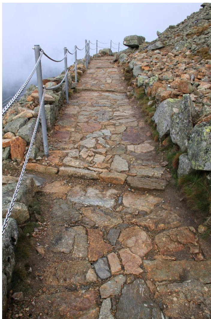
Obr. 26: Štětování s novým zábradlím na západní cestě na Sněžku. Foto autor
