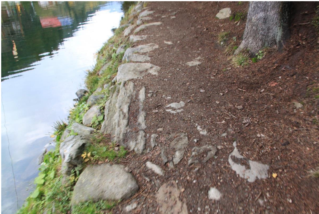
Obr. 35: Štětování chodníku okolo přehrady v Peci pod Sněžkou. Foto autor
