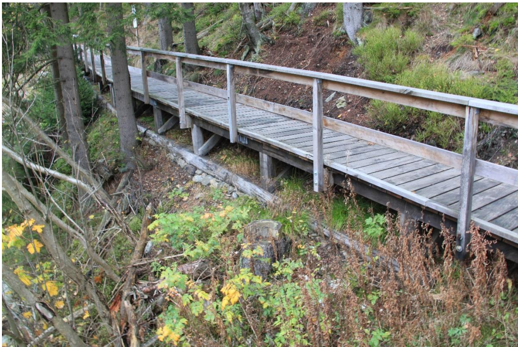
Obr. 16: Povalový chodník z rozměrově menších dílů u vodní nádrže v Peci pod Sněžkou. Foto autor
