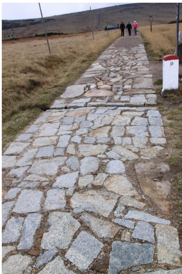
Obr. 11: Rozdílný přístup k rekonstrukci chodníku Jantarové stezky. V popředí polské dláždění, na pozadí české štětování. Foto autor
