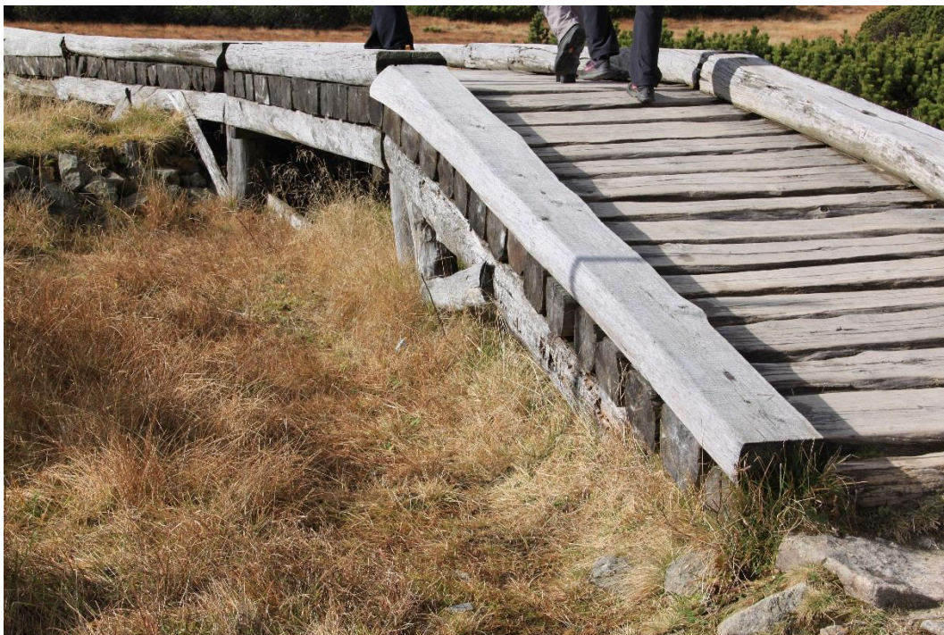
Obr. 15: Povalový chodník nad Úpským rašeliništěm. V popředí nástupní rampa, v pozadí jedna z opěrných zídek. Foto autor
