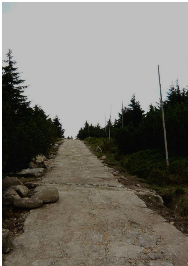
Obr. 28: Štětování v dolním úseku rekonstruovaného chodníku ve směru Vosecká bouda – Svinské kameny. Foto autor
