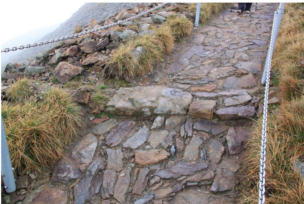
Obr. 25: Kamenné schody ve štětování, které částečně slouží i jako svodnice. Foto autor
