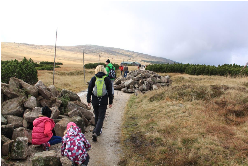
Obr. 31: Probíhající přípravy rekonstrukce chodníku – navážka kameniva. Foto autor
