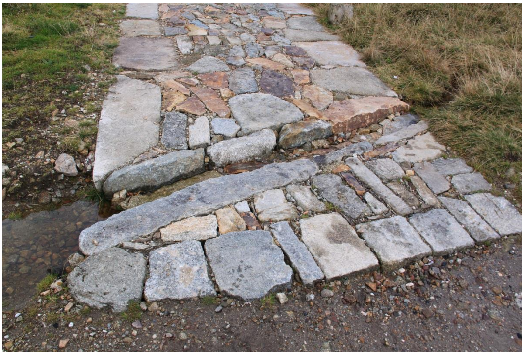
Obr. 18: Začátek štětování Jantarové cesty u Luční boudy s kamennou svodnicí. Foto autor
