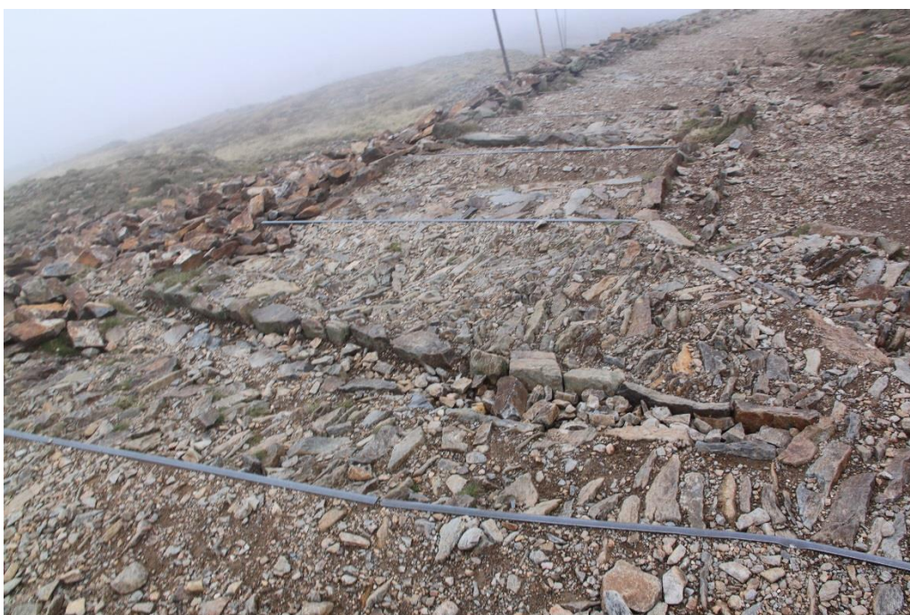
Obr. 10: Rozrušený a neudržovaný štětovaný chodník na jižním svahu těsně pod vrcholem Sněžky. Foto autor
