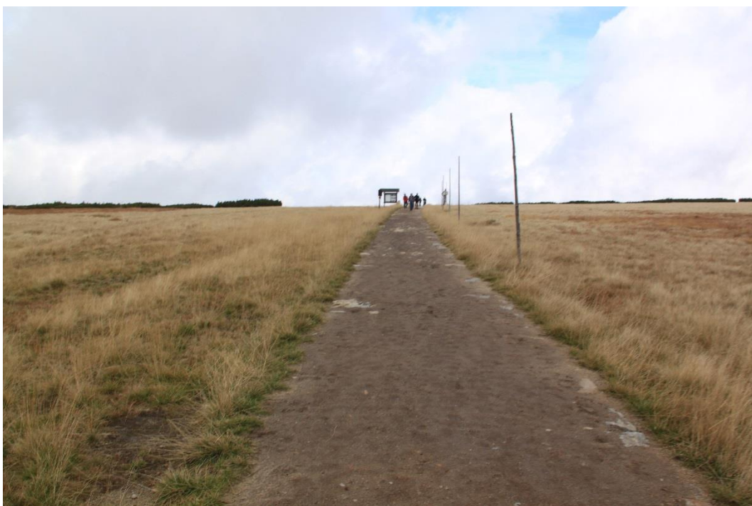
Obr. 20: Štětování Jantarové cesty plně zakryté jemnozrnným materiálem. Foto autor
