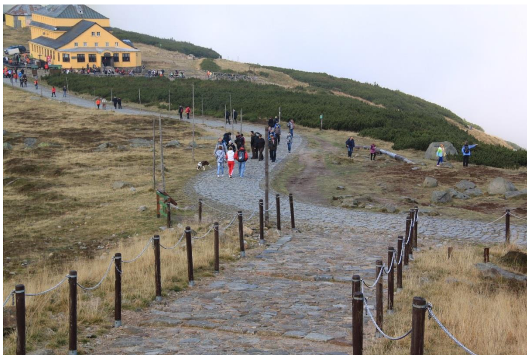
Obr. 23: Napojení chodníku na Jubilejní cestu. Foto autor
