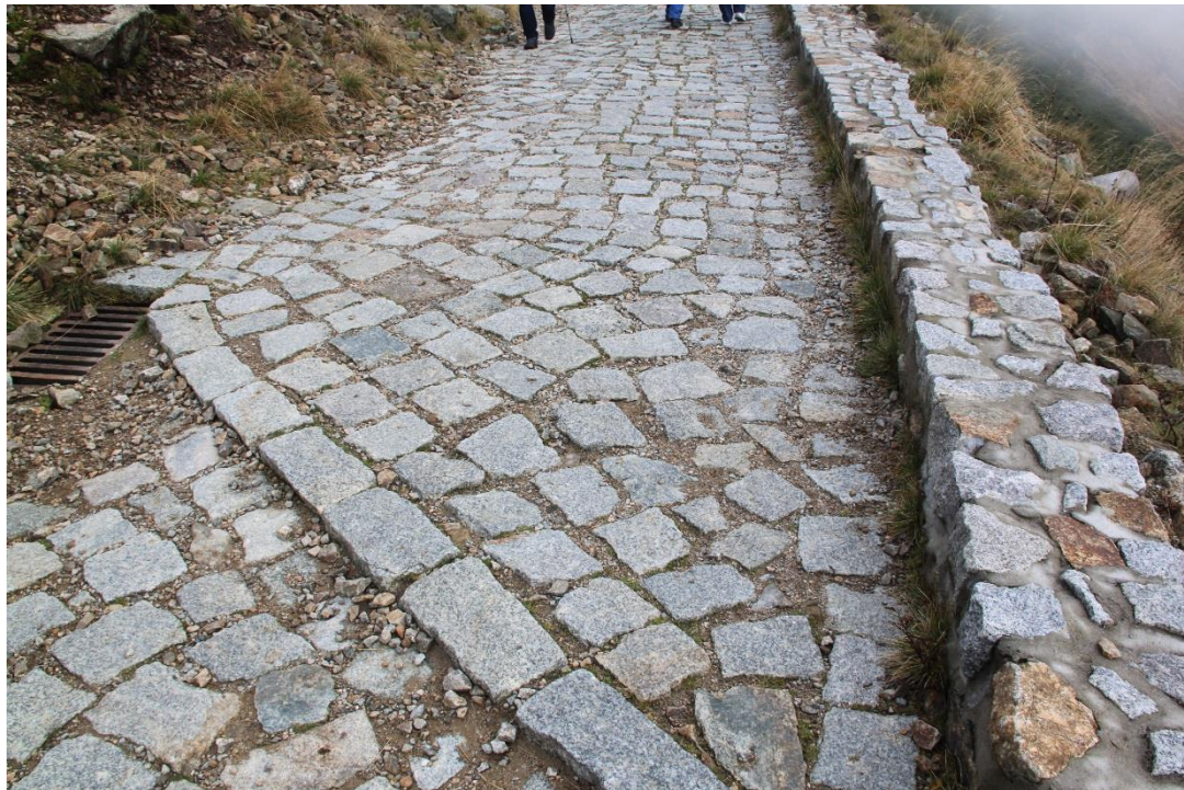
Obr. 4: Dláždění Jubilejní cesty se svodnicí vedoucí k vnitřní straně cesty. V pravém horním rohu fotografie je patrná v trávě trubka, kterou je voda převáděna na vnější stranu. Foto autor
