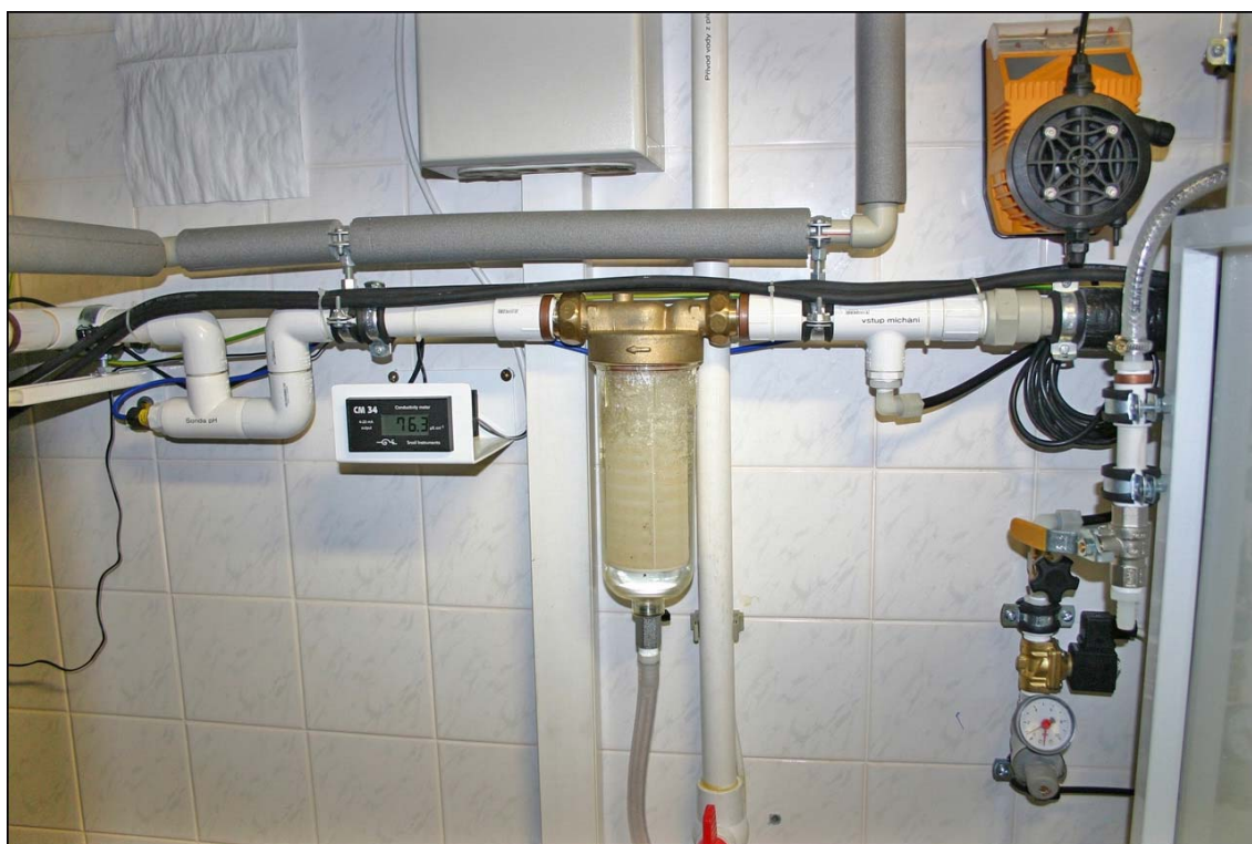
Foto 5. Míchání permeátu a koncentrátu na požadovanou kvalitu (vodivost) výstupní vody pro zálivku
