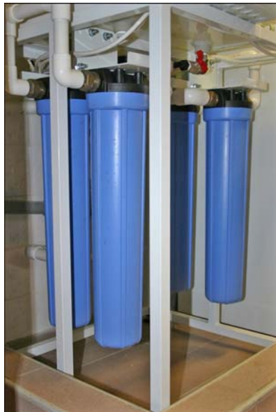
Foto 2. Svíčková předfiltrace 5 \mu\text{m} před reverzní osmózou
