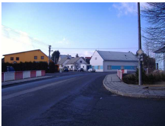
Obrázek 5.16: L most na silnici č. 01876 v obci Zašová
