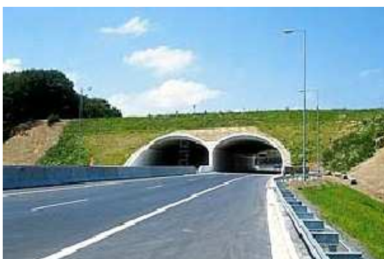
Obrázek 5.8: D tunel poblíž obce Dolní Újezd
