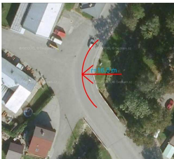
Obrázek 5.17: M křižovatka na silnici č. 01876 v obci Zašová
