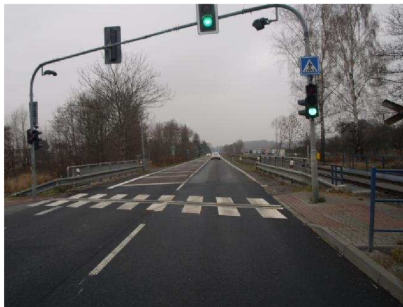
Obrázek 5.14: J most na silnici I/35 v obci Zašová
