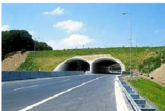
Obrázek 5.8: D tunel poblíž obce Dolní Újezd
