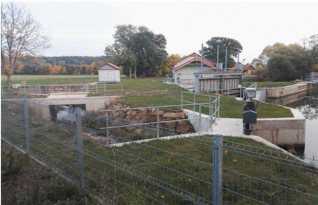
Obr.47 MVE Heřmanice I, MVE Heřmanice II
