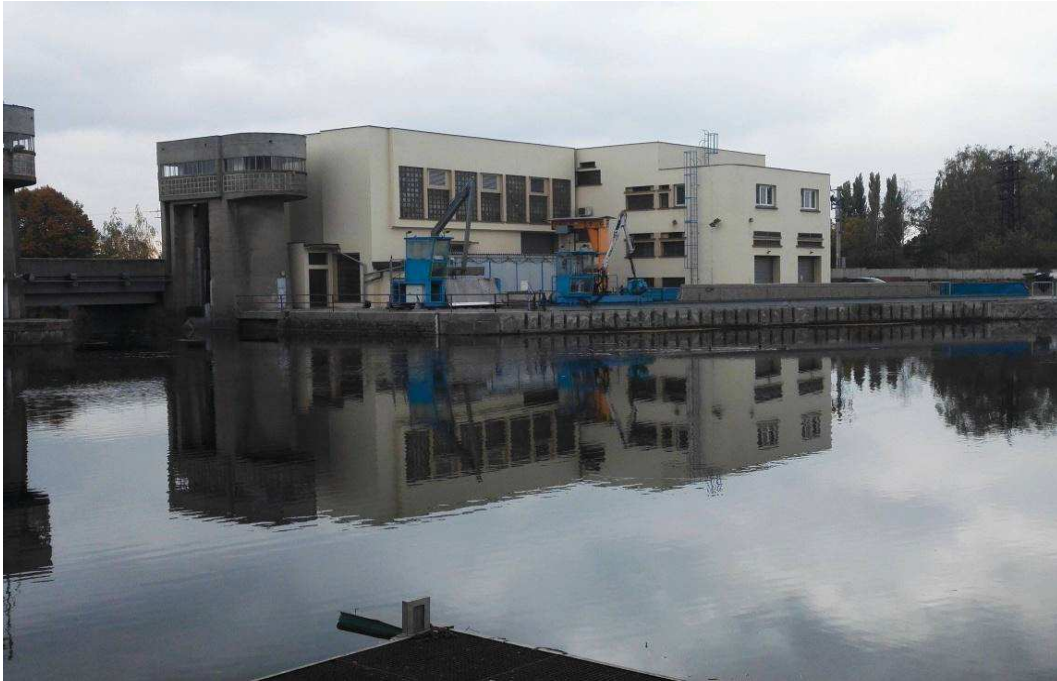
Obr.60 MVE Předměřice nad Labem (pohled po proudu řeky)
