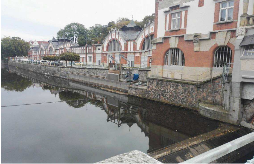
Obr.64 MVE Hučák (pohled z mostu nad vývarem)
