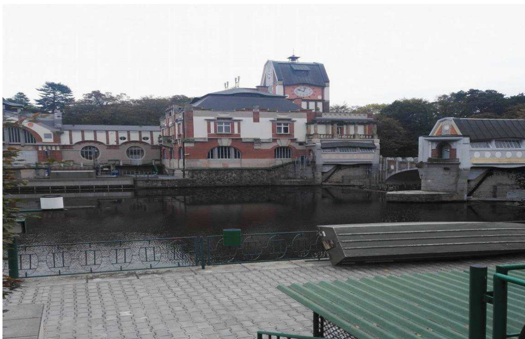
Obr.63 MVE Hučák (pohled z pravého břehu)
