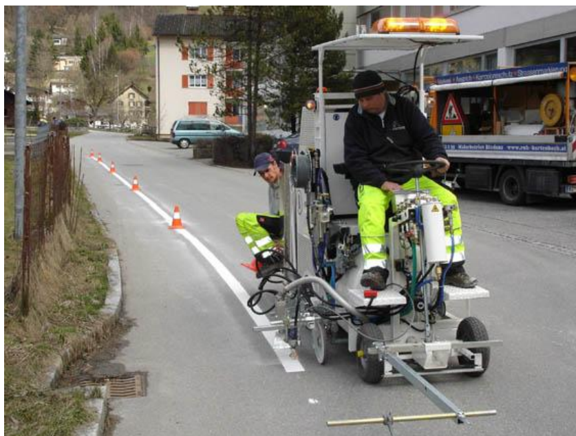
Obr. 13. Samohybný stroj Hofmann H11-1 [10]
