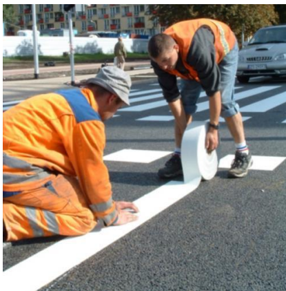
Obr. 10. Lepení vodorovného dopravního značení [6]
