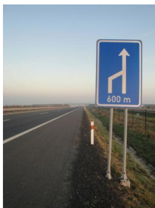
Obr. 3. Stálá svislá značka umístěna vedle vozovky [15]
