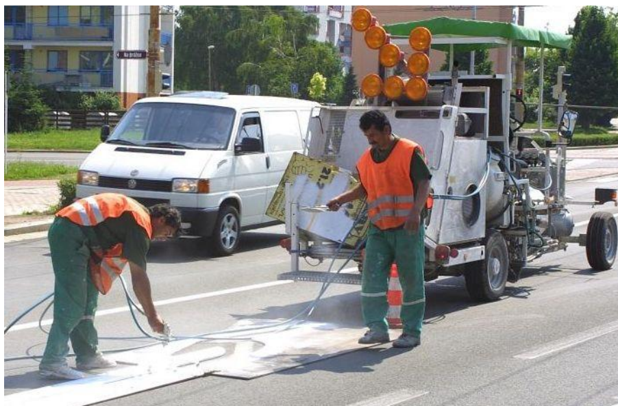
Obr. 11. Ruční nástřik vodorovného značení do formy [8]
