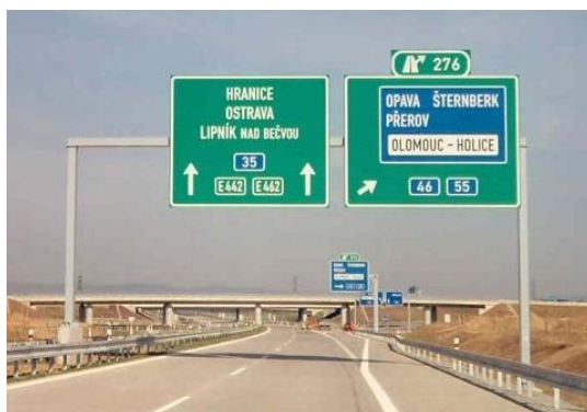
Obr. 4. Stálá svislá značka umístěna nad vozovkou [16]
