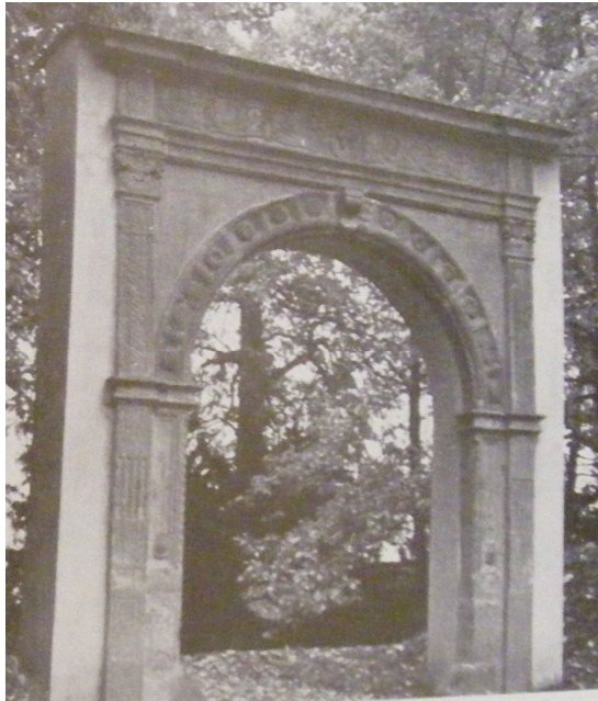
64. Portál bývalého domu v Lošticích, dnes Bílá Lhota. Foto: Hana Myslivečková, Příspěvek k počátkům a podobě renesanční architektury a plastiky v Litovli, in: Acta Universitatis Palackiana Olomucensis facultas paedagogica, Aestetica 5 . Praha 1985, s. 37.
