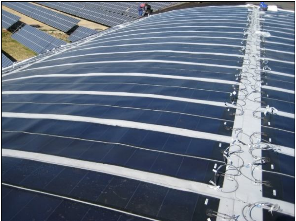
Obrázek č. 20: Hydroizolační fólie na bázi amorfního křemíku, zdroj: http://www.aelsolar.cz/produkty/fatrasol.html (2012)
