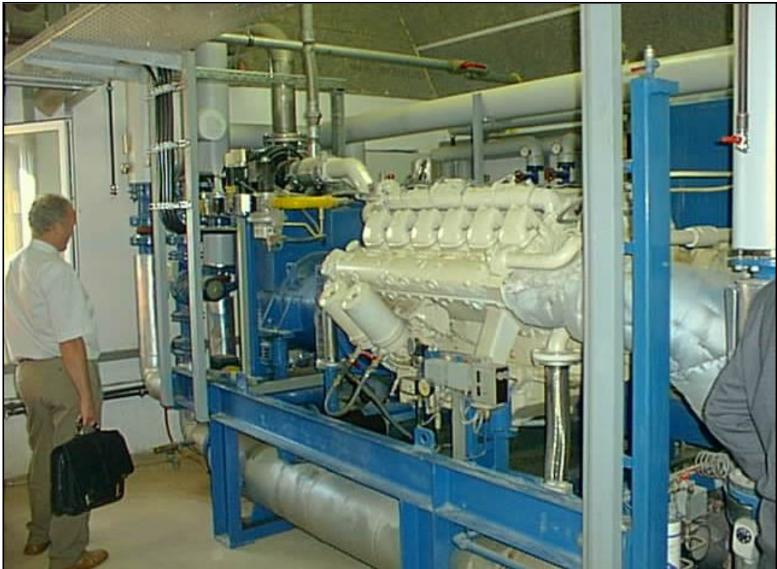
Obrázek č. 7: Kogenerační jednotka, zdroj: http://biom.cz/cz/odborne-clanky/bioplyn-v-nemecku (2003)
