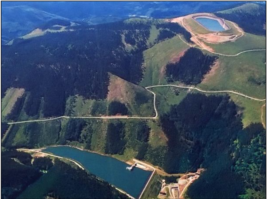
Obrázek č. 39: Přečerpávací vodní elektrárna Dlouhé Stráně, zdroj: http://buddymag.cz/data/images/texty/big/pve_ds_i_a_ii_aerofoto.jpg (2012)
