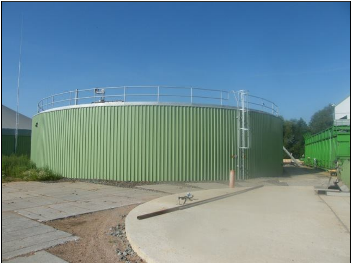
Obrázek č. 3: Vertikální konstrukční typ reaktoru v Jaroměři, zdroj: http://www.bioplynes.cz/bioplynova_stanice_jaromer (2012)
