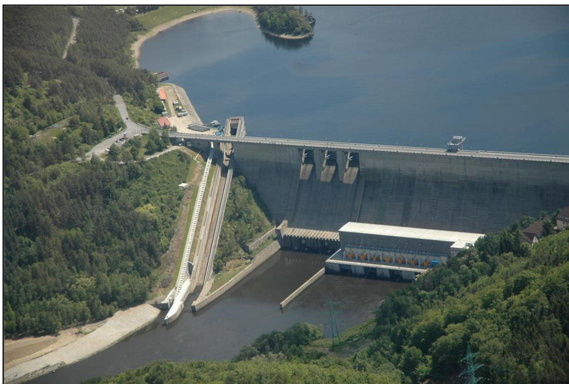
Obrázek č. 36: Akumulační vodní elektrárna Orlik, zdroj: http://www.akpm.cz/phprs/view.php?cisloclanku=2007060001 (2012)
