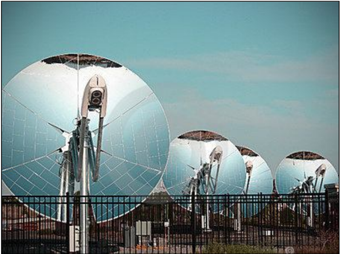
Obrázek č. 25: Koncentrující solární kolektory v provedení tzv. solárních talířů, zdroj: http://asolarheater.net/201-parabolic-dish-solar-collector.html (2012)
