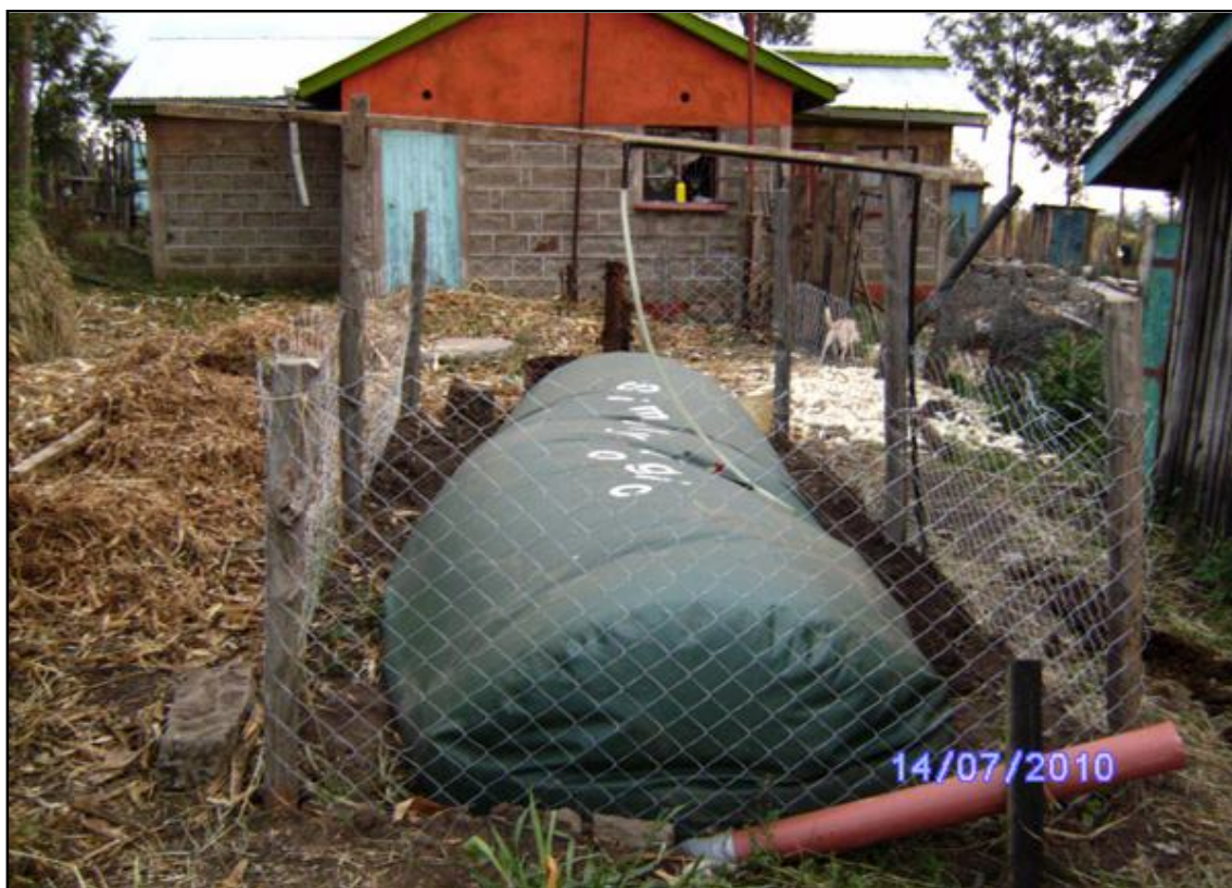
Orázek č. 11: bioplynová stanice typu plastového vaku, zdroj: http://www.biogas.co.ke/ (2010)
