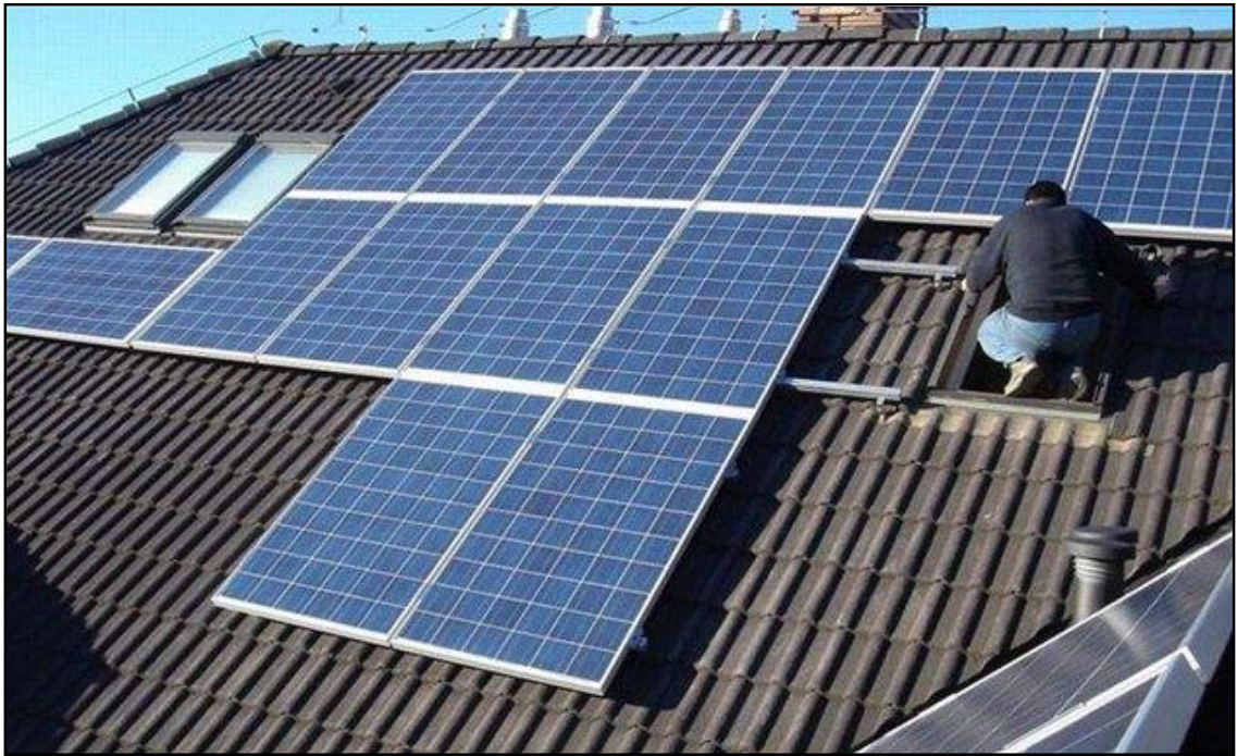
Obrázek č. 21: Fotovoltaické panely instalované na střeše rodinného domu, zdroj: http://hobby.idnes.cz/fotovoltaicke-panely-jsou-investici-jakou-nenabidne-zadna-banka-pxf/hobby-domov.aspx?c=A090421_172846_hobby-domov_bma (2009)
