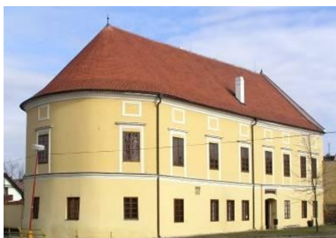
31 Litovel, muzeum (dřívější měšťanská střelnice), 1872, pohled od východu.
