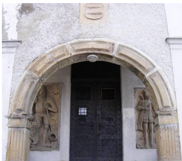
23 Litovel, Sochova vila, 1572, Husova ulice č. p. 805, portál.
