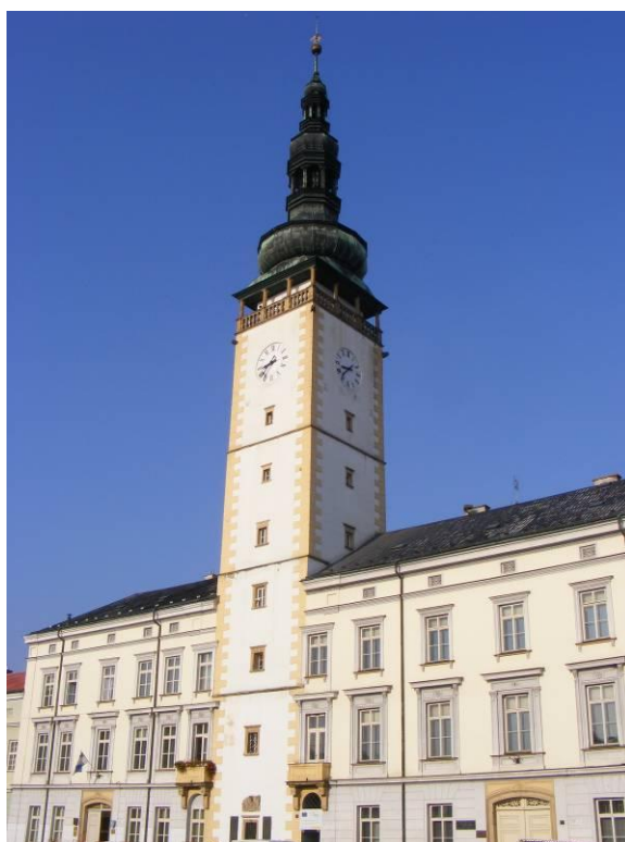
14 Litovel, radnice, 1684, západní průčelí.
