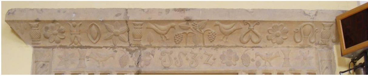
42 Litovel, kostel sv. Marka, 1532, detail portálu sakristie.
