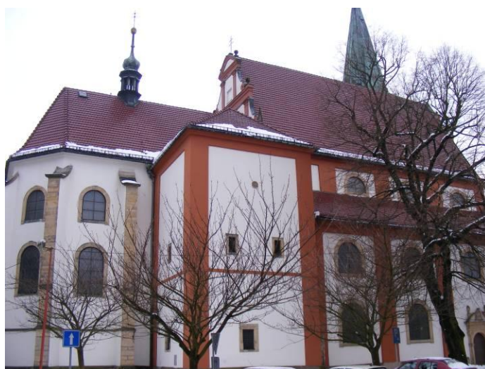
37 Litovel, kostel sv. Marka, 1675-1680, pohled ze severu.
