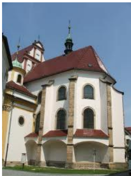
36 Litovel, kostel sv. Marka, 1675-1680, pohled z východu.
