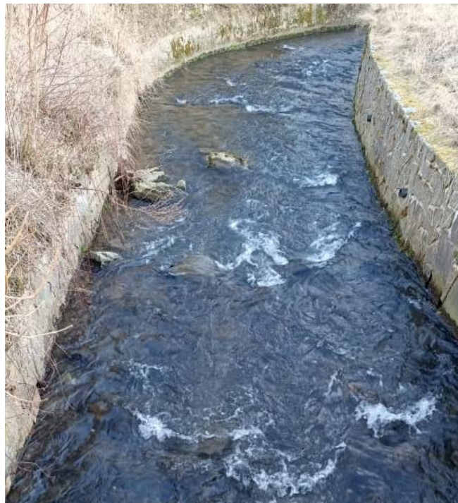
Obrázek 9: Jáchymovský potok, úsek č. 1, fotografie autor
