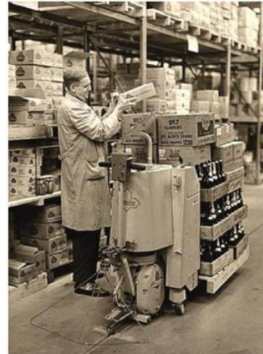
Obrázek 3: AGV vozík “Teletrak” od společnosti Jungheinrich , elektrické vedení. [1]
