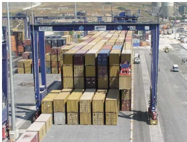
Obrázek 16: Satelitní navádění venkovního jeřábu. [3]
