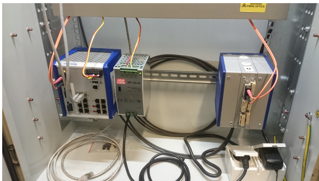
Obr. C.6: Vedľajší rozvádzač T - prepojenie prvkov
