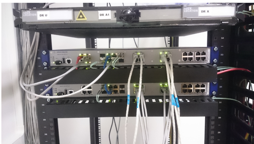
Obr. C.2: Serverovňa - Prepojenie MACH104
