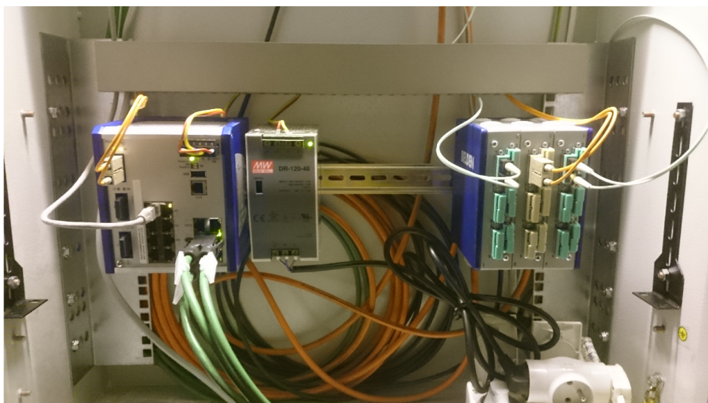
Obr. C.4: Zapojenie rozvádzača hlavného optického rozvodu
