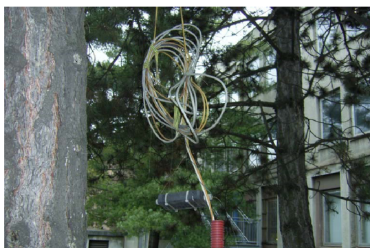
Obr. 5.2: Ukončenie optickej vetvy.
