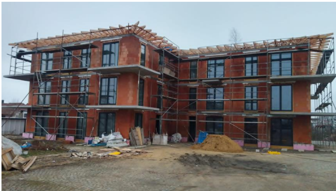
Obrázek 5 - Reálná stavba, Zdroj: [vlastní zpracování]
